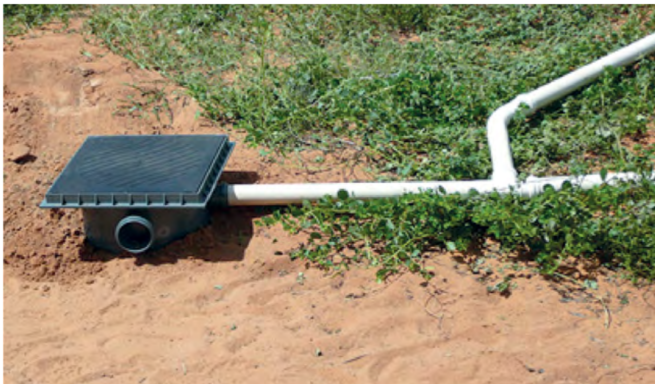
7 – Finalizando o ponto de convergência das águas cinzas para a caixa de gordura.
