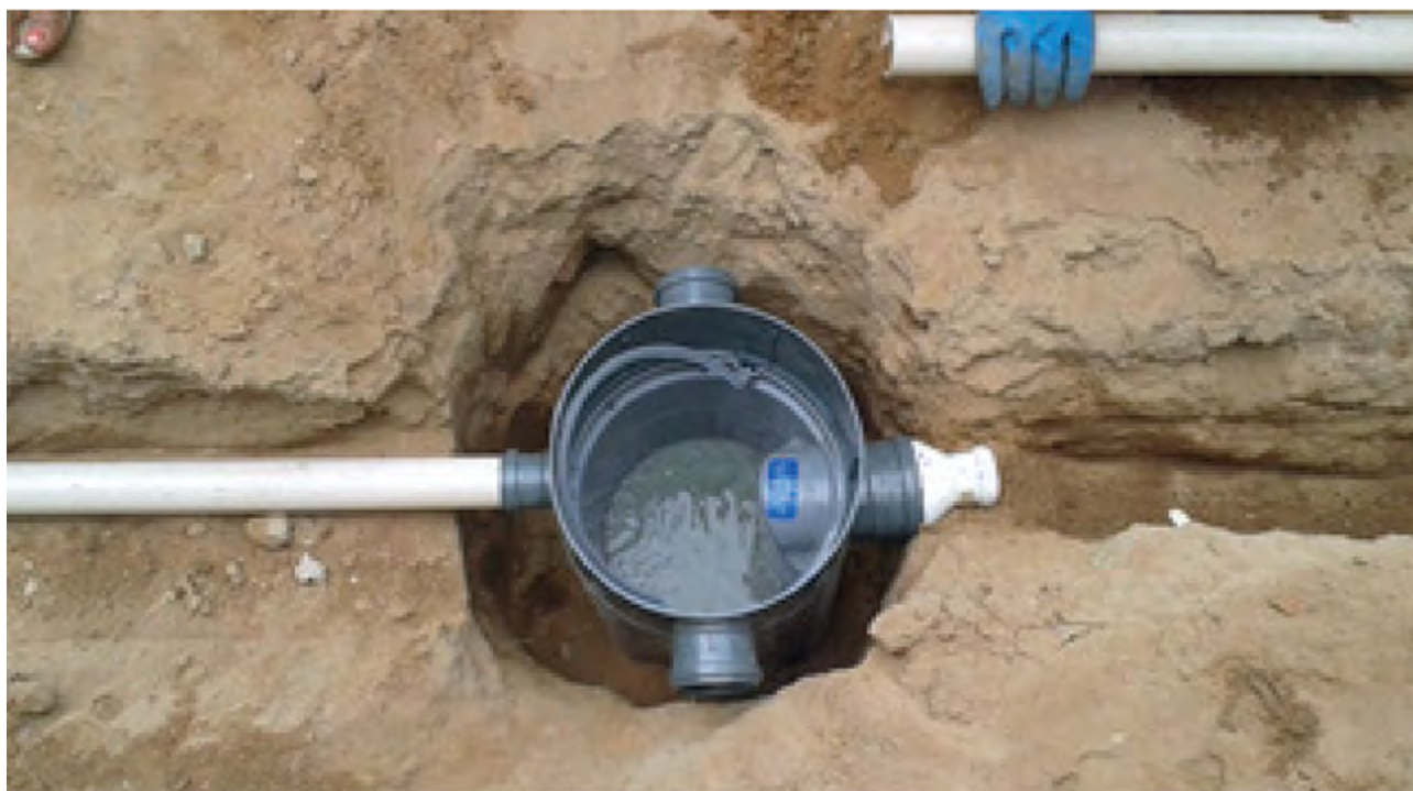
6 – Finalizando o ponto de convergência das águas cinzas para a caixa de gordura DN 300 que possui 3 entradas (uma de 50 mm e duas de 75 mm) e uma saída (100 mm). Na saída é colocada uma redução de 100 mm para 50 mm que servirá para conectar o tubo de PVC DN 50 que levará a água para o filtro biológico.
