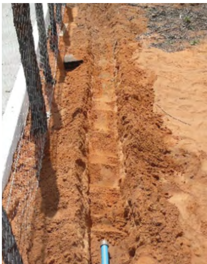
48 – Vala para aterrar a linha de derivação composta de mangueira de polietileno de DN 16.
