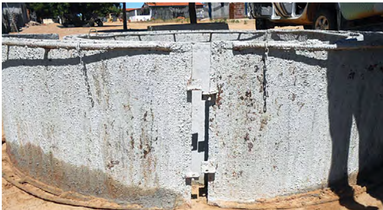
Figura 30. Peça curva externa sendo encaixada.
