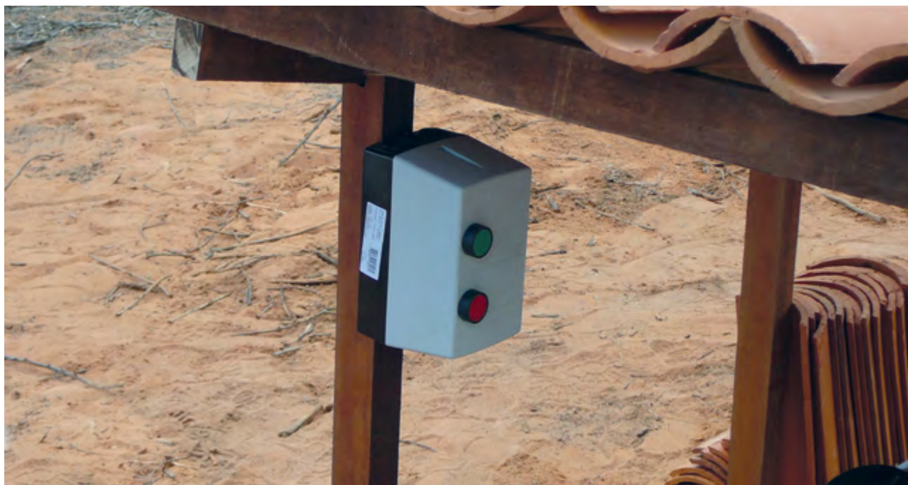
7 – Na chave magnética o botão verde serve para ligar e o vermelho para desligar a eletrobomba.
