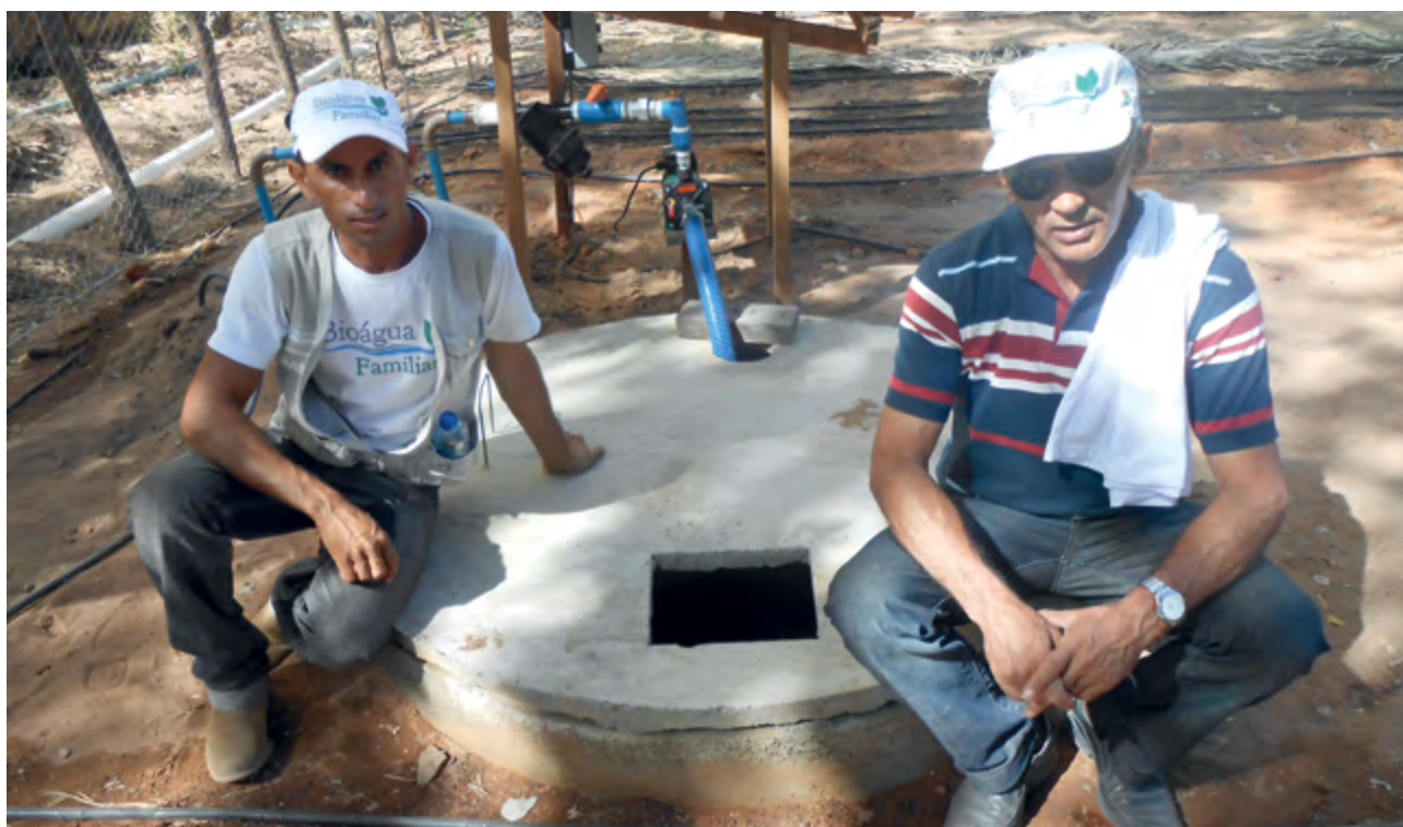
16 – Tanque de reúso finalizado.
