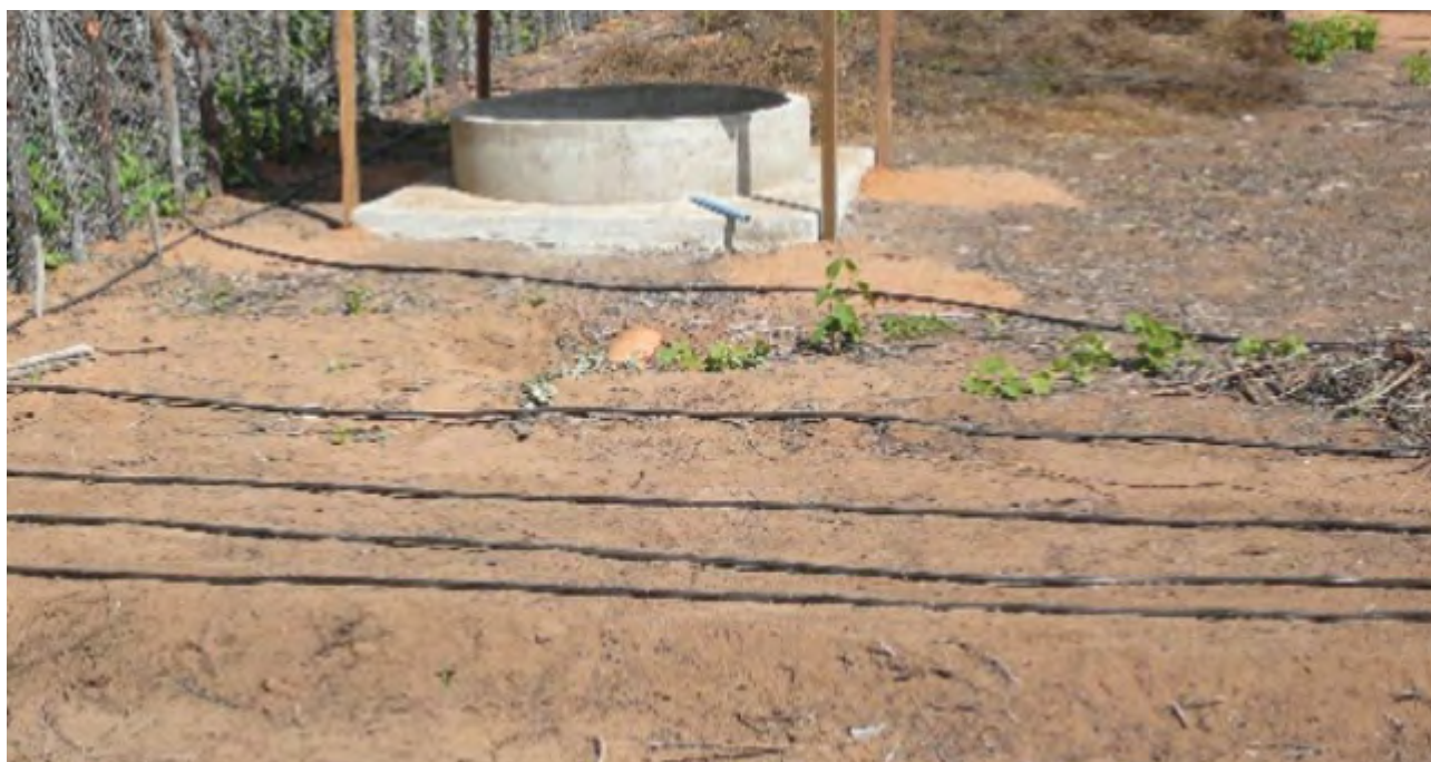
62 – Finalização da instalação das linhas laterais de polietileno DN 16 com gotejadores para os canteiros e uma linha com gotejadores para a produção de hortaliças do tipo fruto (tomate, berinjela, pimentão, etc.).
