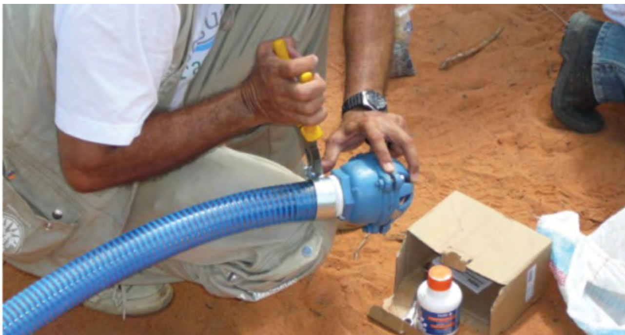
35 – Colocando a válvula de pé de 2" ferro fundido no mangote, usando um adaptador para válvula de pé 2" x 50 mm e uma abraçadeira para mangote de 50 mm.
