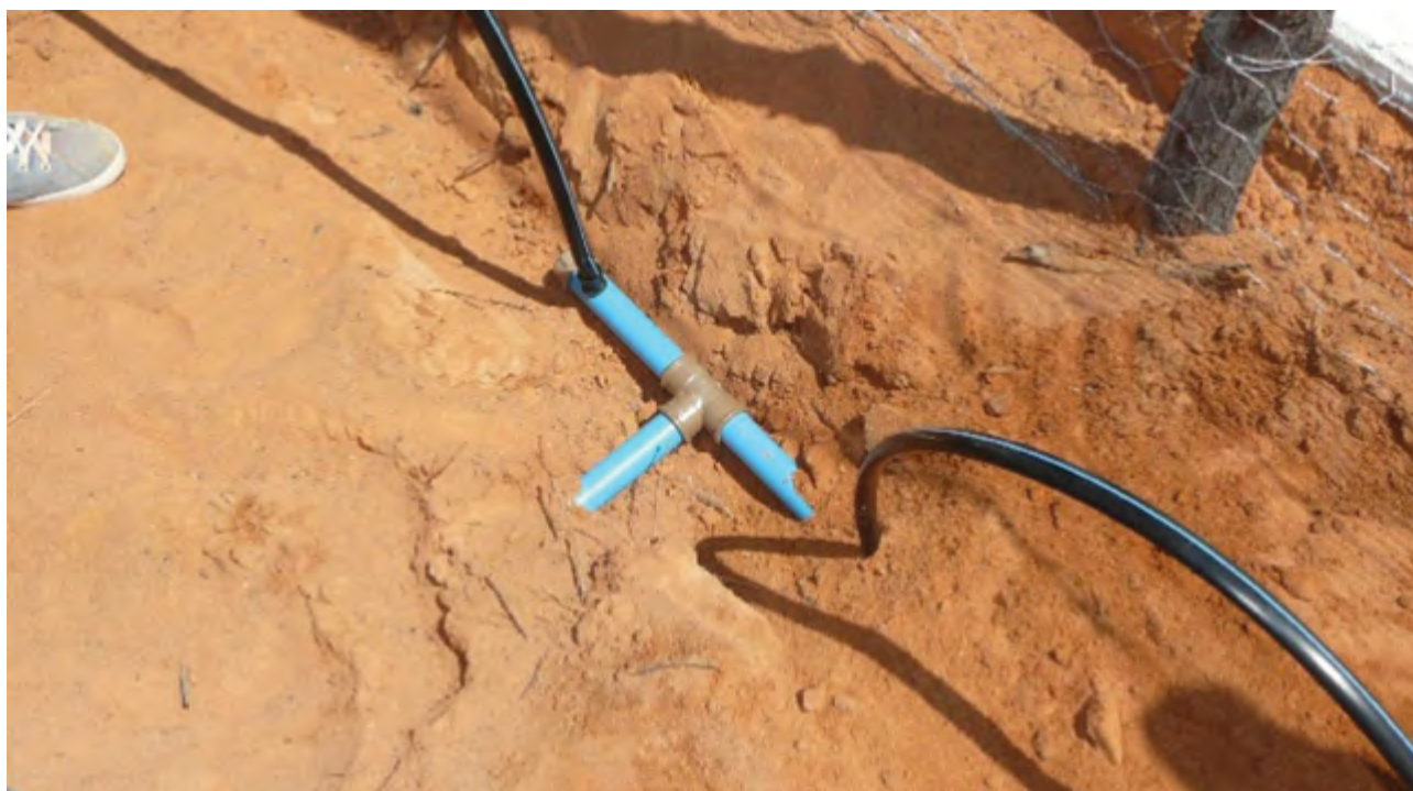
50 – Linhas de derivação DN 16 conectadas aos inícios de linha de 16 mm.
