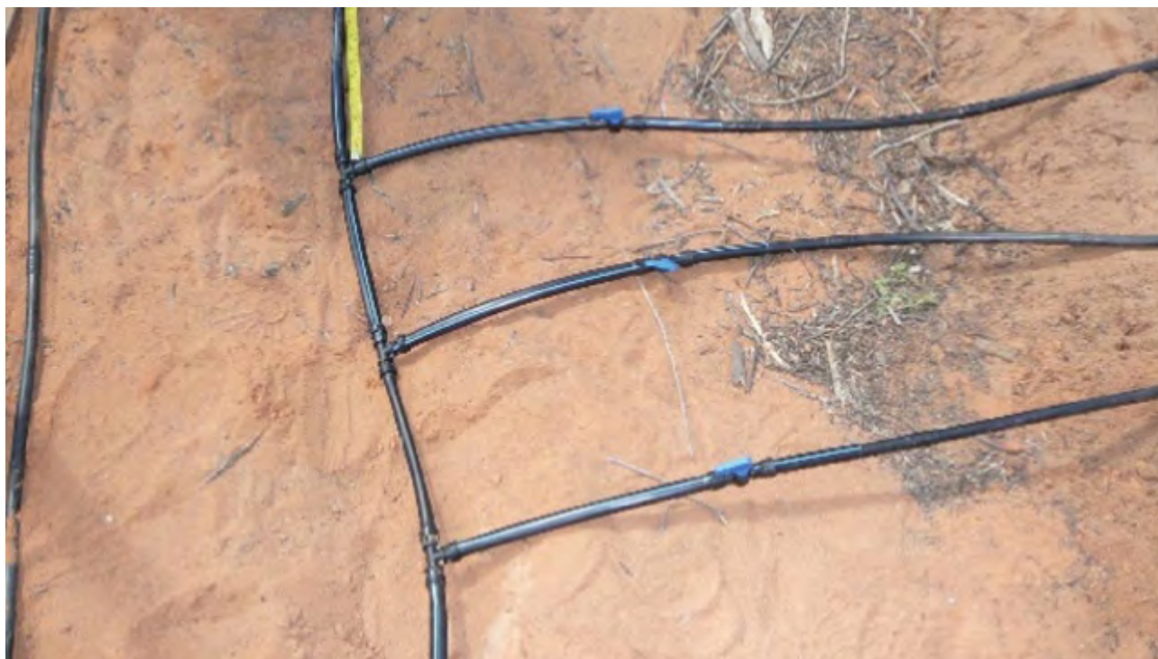
59 – Linhas de polietileno DN 16 com gotejadores para ofertar água para os canteiros de hortaliças, utilizando 25 cm de espaçamento entre linhas.
