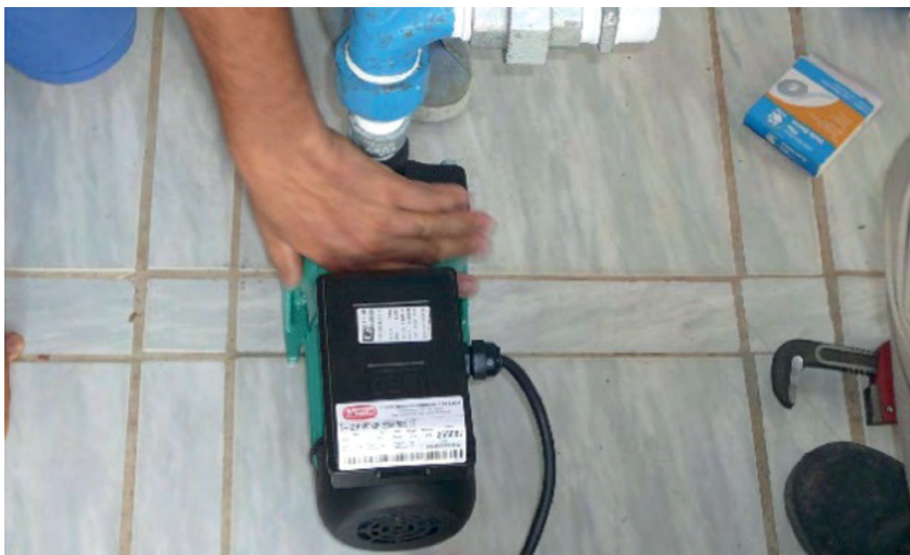
25 – Montagem da eletrobomba centrífuga 1/2 CV.
