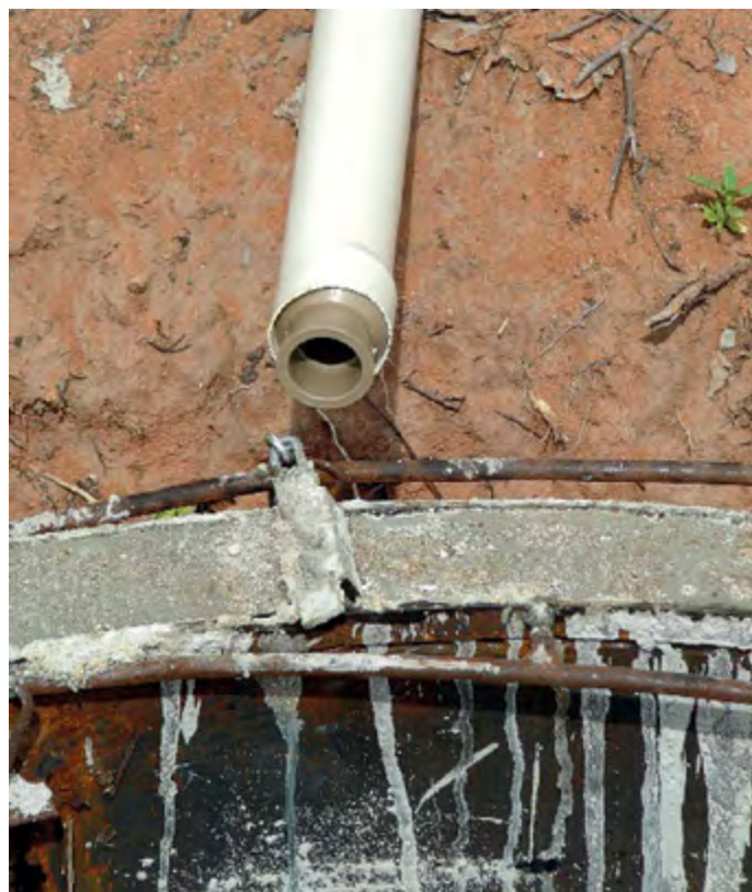
11 – Detalhe da redução de 50 mm para 32 mm.
