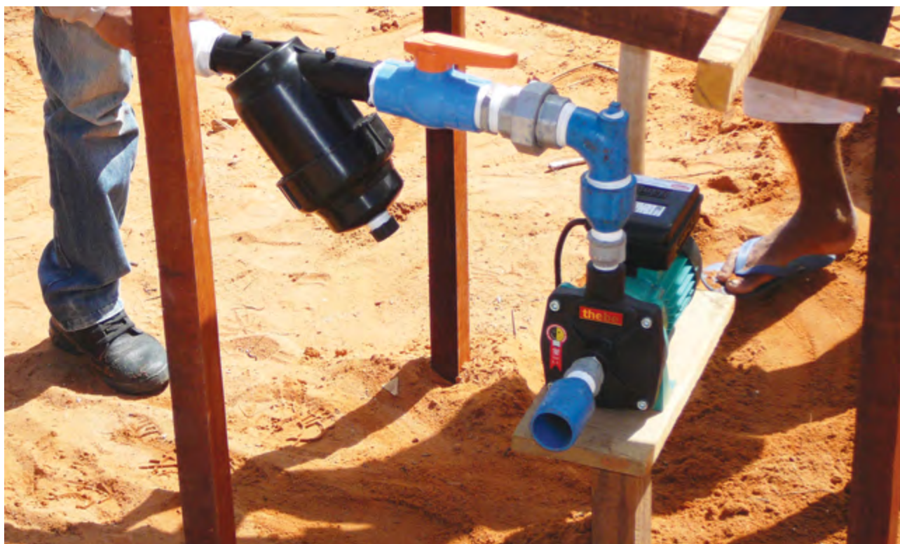
32 – Eletrobomba completa (sucção e recalque).
