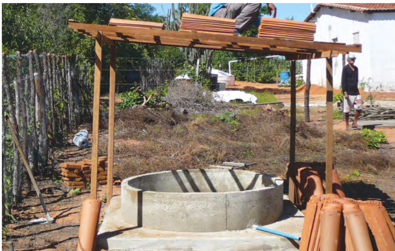
13 – Para finalizar, colocar 230 telhas na armação da coberta.
