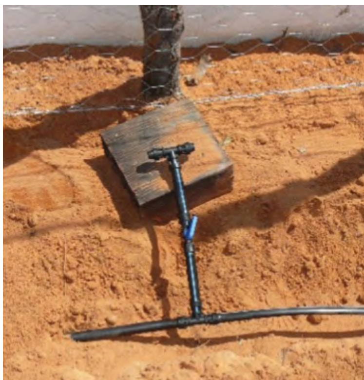
52 – Conectando a linha lateral (para irrigação das árvores da cerca viva) através de um Tê de polietileno de 16 mm na linha de derivação, 10 cm de mangueira de polietileno de 16 mm e um registro de 16 mm.
