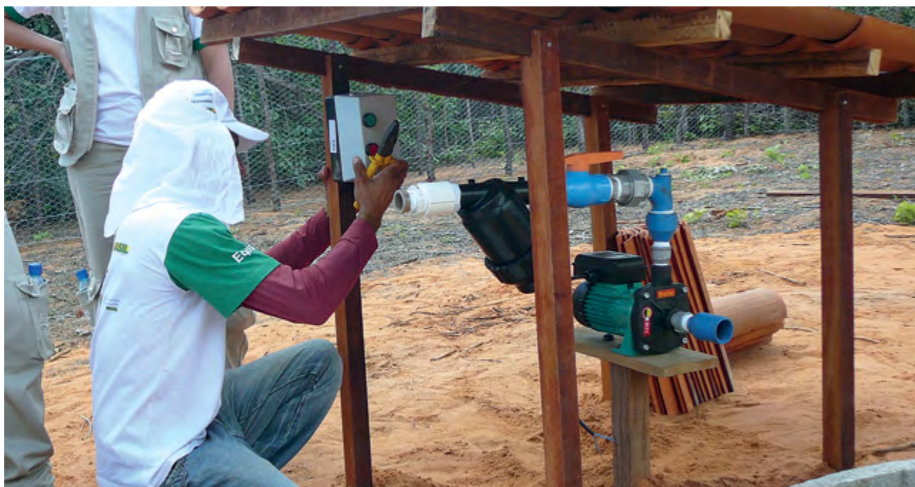
6 – Fixar a chave magnética em um dos barrotes da cobertura da eletrobomba com parafuso ou prego.
