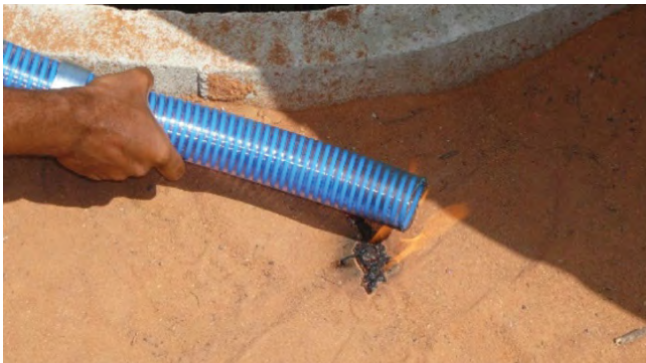
38 – Aquecendo o mangote para a entrada na eletrobomba.
