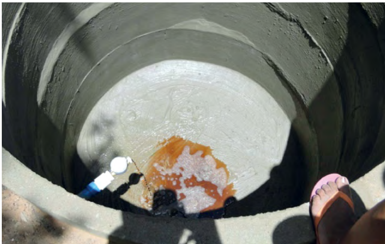
23 – Conexões do hidrômetro: adaptador de 50 mm x 1/2", luva rosca plástica 1.1/2", bucha de redução plástica de 1.1/2" x 1".
