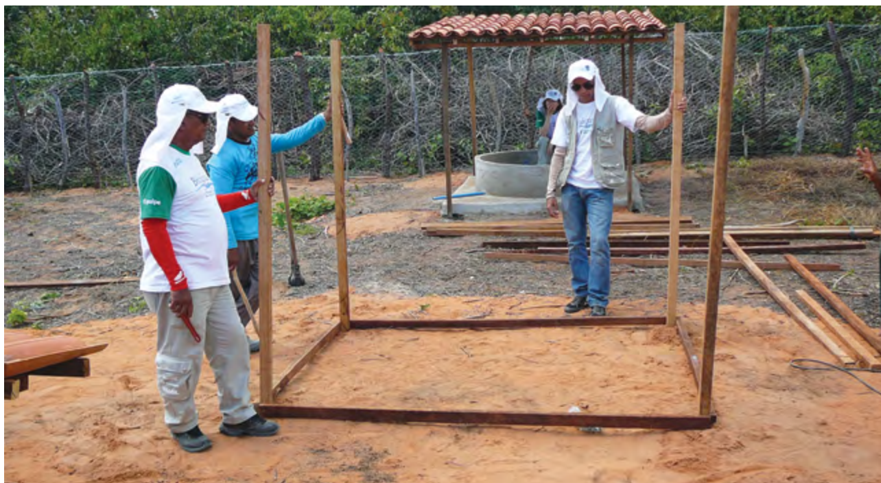
3 – Colocar 4 caibros na base da estrutura que servirão para unir os 4 barrotes e prender o sombrite. Fixar os caibros nos barrotes utilizando pregos.
