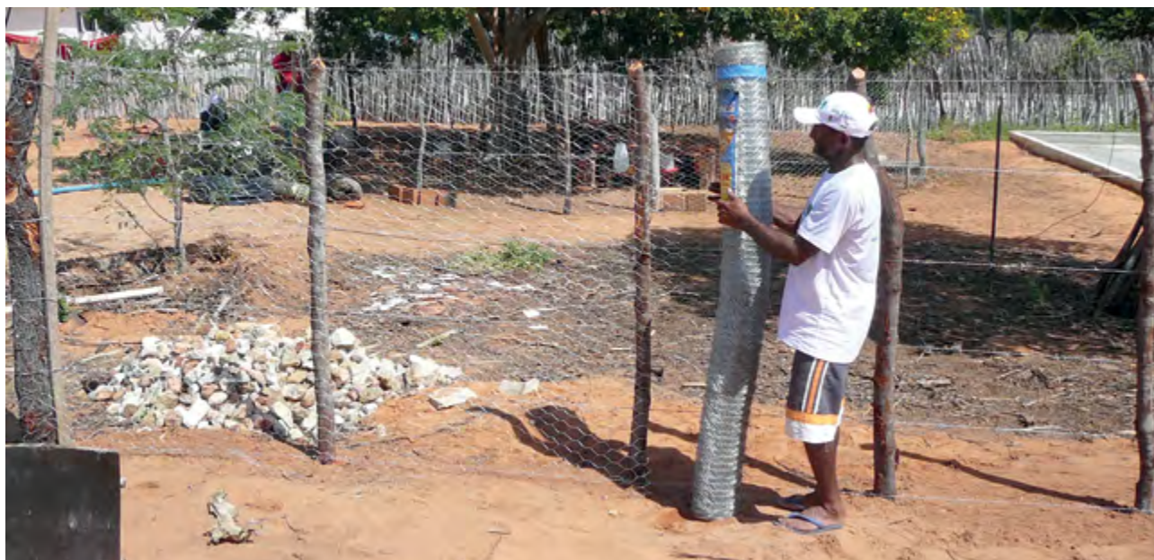
5 – Colocar tela galvanizada (tipo galinheiro) para fechar a área.
