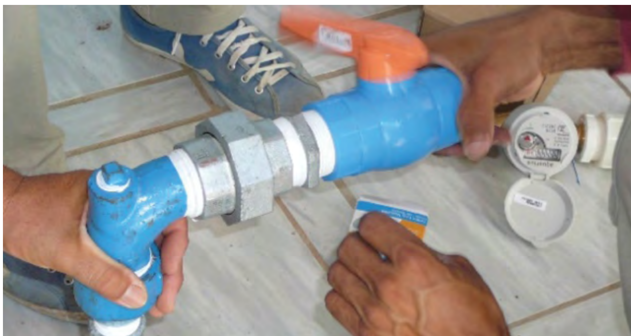
27 – Montagem do sistema de recalque.
