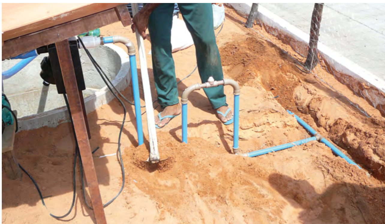
47 – Eletrobomba e cavalete completos.
