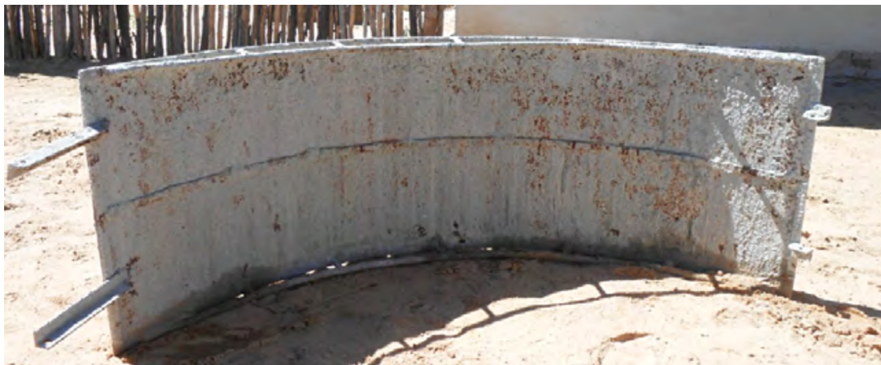
Figura 23a. Peça curva interna da forma (1,55 m). Os dois ferros que passam (25 cm) servem para facilitar a montagem e desmontagem da forma. É a última a ser encaixada na montagem e a primeira a ser retirada na desmontagem da forma.
