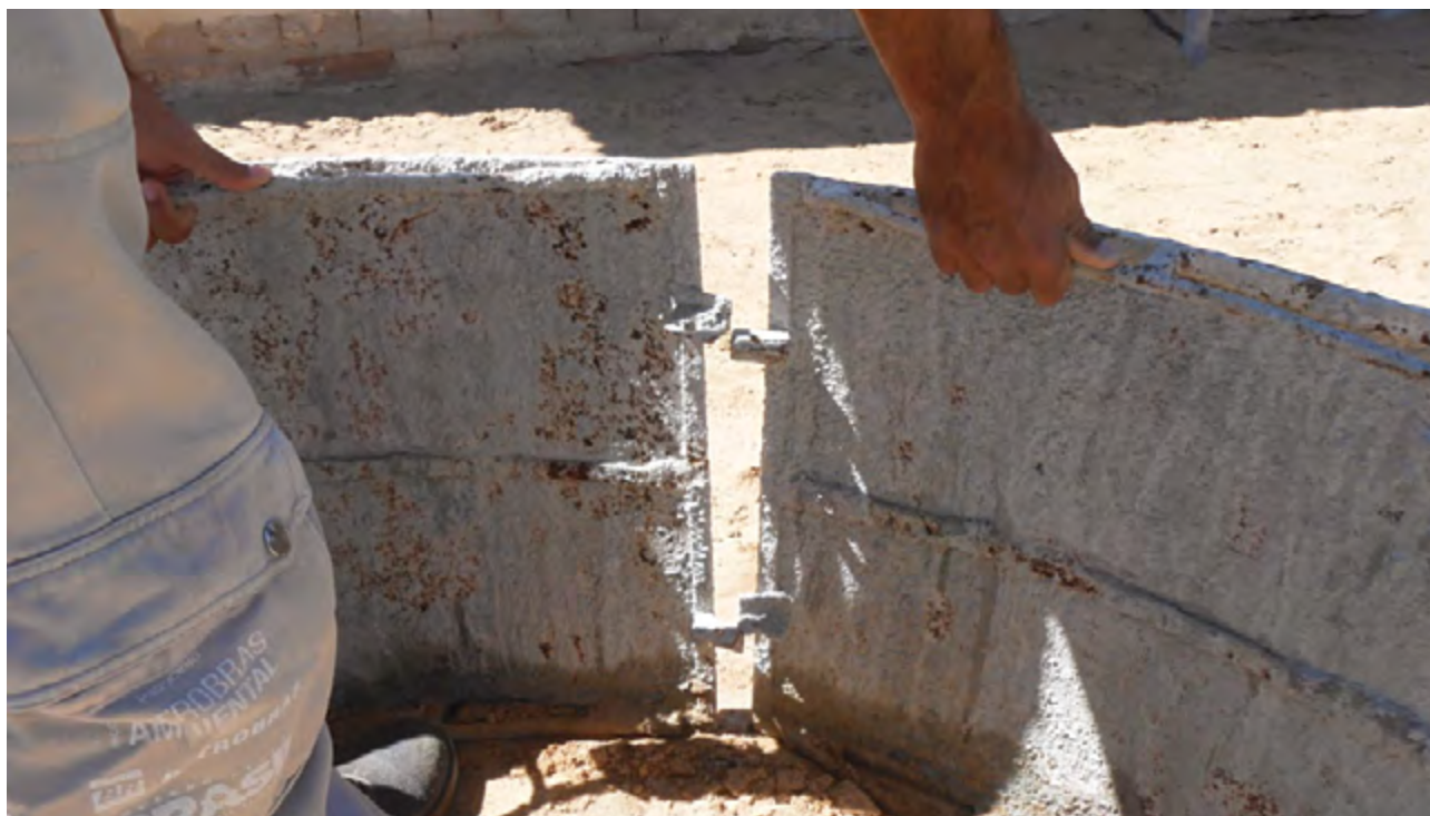
Figura 25. Peças curvas internas de 1,55 m sendo encaixadas.
