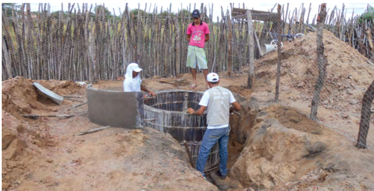
6 – Retirar primeiro as formas de dentro do anel e só em seguida as de fora.
