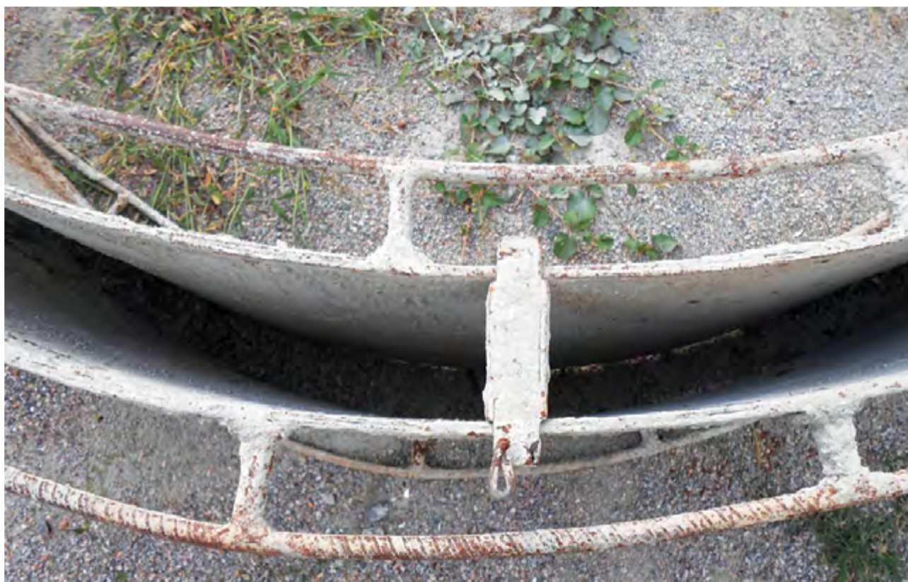
Figura 32. Vista superior com detalhe do “separador” das formas para manter a largura de 6 cm.
