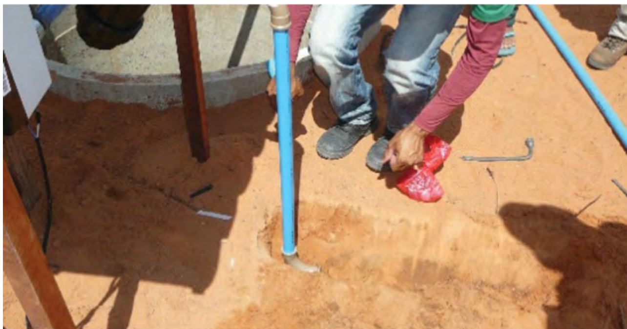
43 – Conectando um tubo de PVC de DN 32 com cerca de 60 cm de comprimento.
