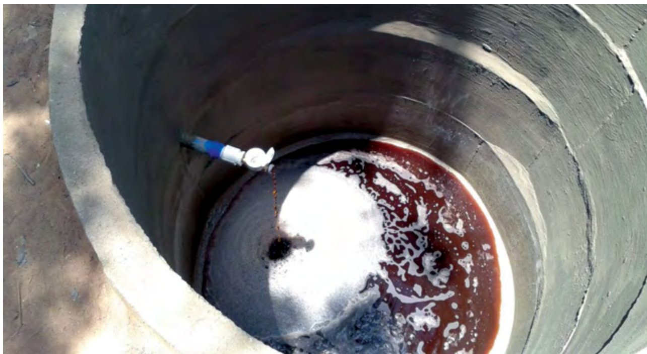
15 – Tanque com os 4 anéis e o hidrômetro de 1". Somente os encaixes do fundo e os 2 primeiros anéis são vedados com cimento e água ("goulda").
