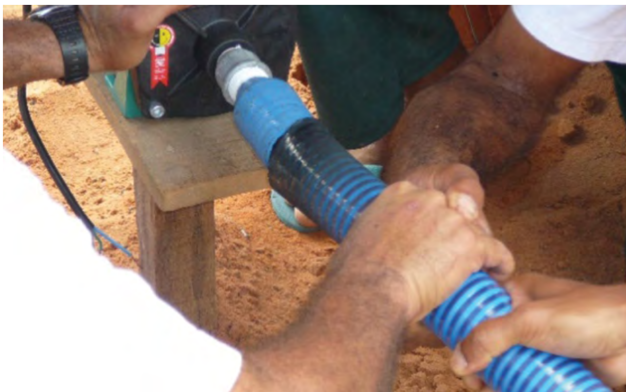
39 – Conectando o mangote no adaptador da eletrobomba.
