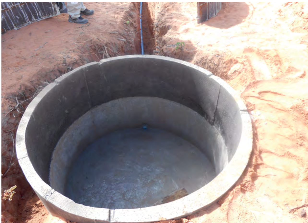
7 – Após a confecção dos anéis, deve ser feito o piso. Para isso, é necessário: \frac{3}{4} saco de cimento; 0,165 \text{ m}^3 de areia (equivalente a 5,5 latas) e 2 latas de água (considerando areia seca).
