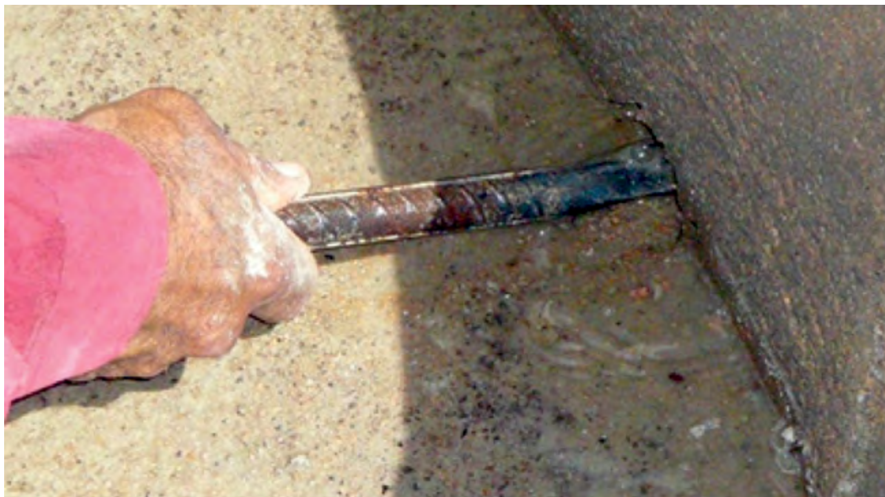
18 – Perfuração do orifício que servirá para a conexão de um tubo de PVC de DN 50 que ligará o filtro biológico ao tanque de reúso.
