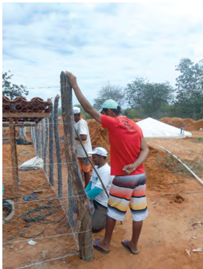
6 – Fixar a tela nas estacas e mourões em três pontos (superior, mediana e inferior), utilizando grampos.
