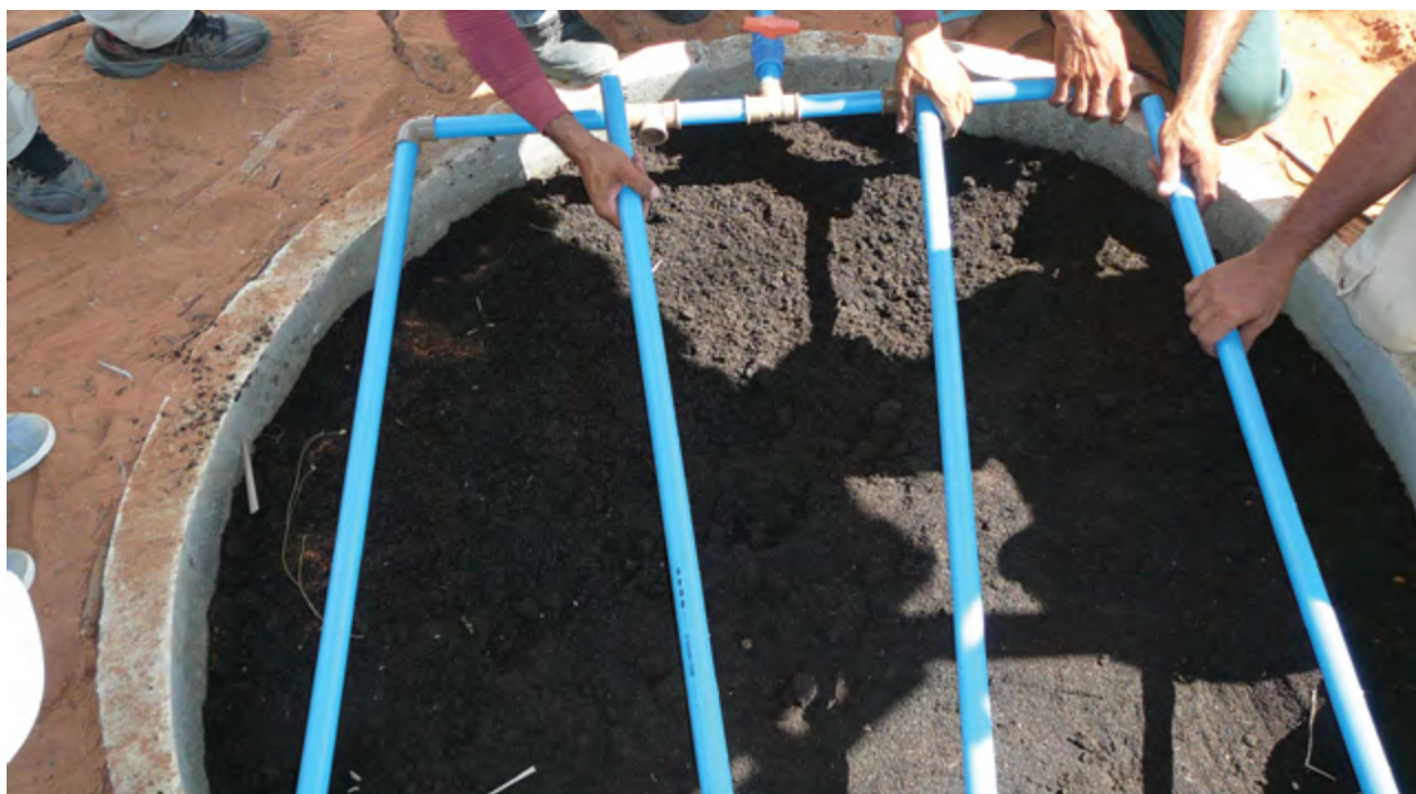
14 – Medição do tamanho dos tubos de PVC que serão utilizados para a confecção do “chuveiro”.
