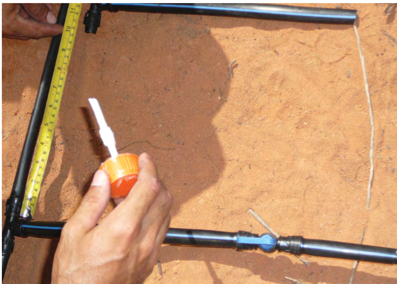
55 – Nos canteiros de hortaliças conectar 3 Tês de polietileno com espaçamento de 25 cm entre cada um.
