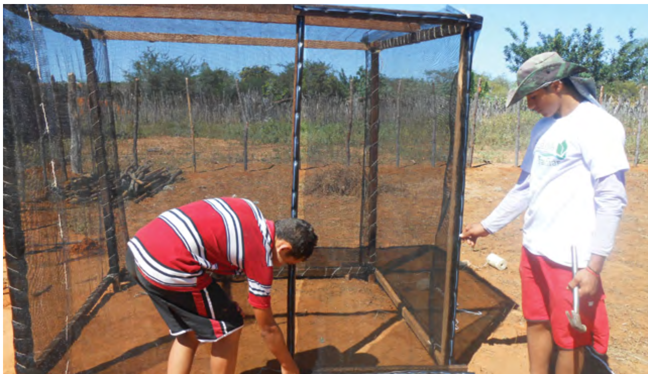
9 – Fixar o sombrite na parte externa da porta com mangueira de polietileno presa com pregos. Na parte inferior da porta, fixar um caibro de 80 cm.
