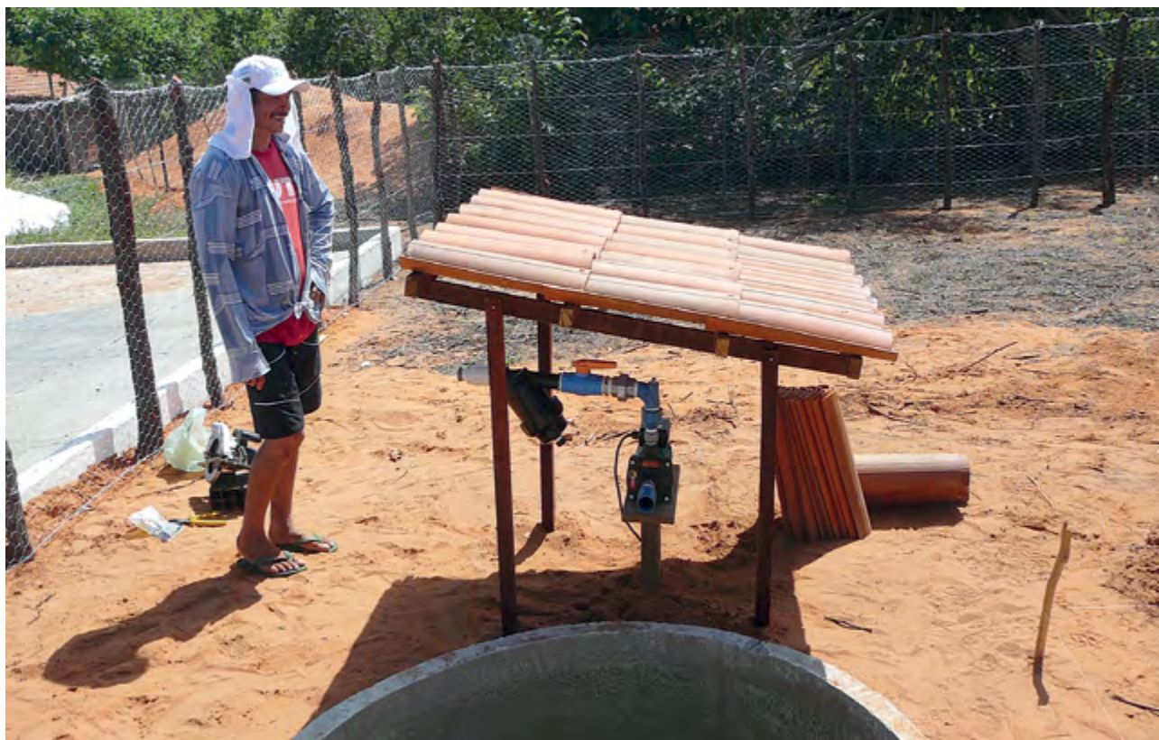
5 – Para finalizar, cobrir a estrutura com 54 telhas.
