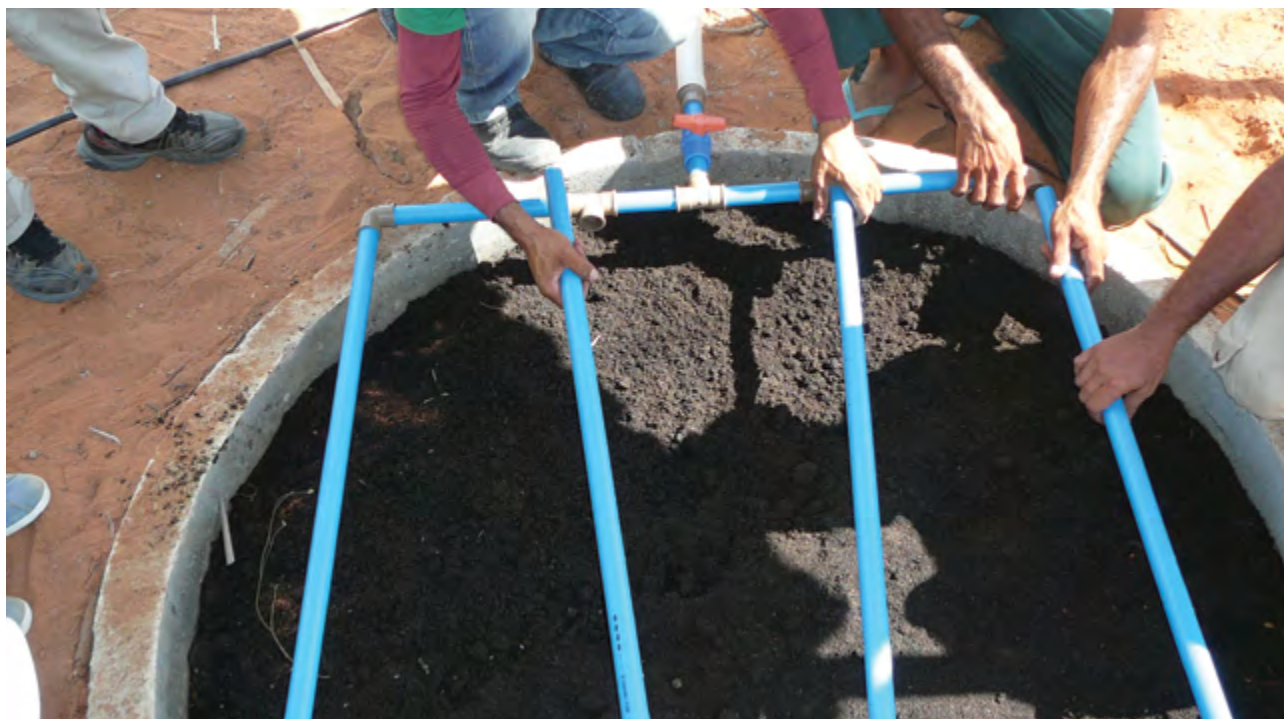
16 – Montagem do “chuveiro” utilizando 2 tubos de PVC DN 32 com 1,33 m e 2 tubos de PVC de DN 32 com 1,47 m.
