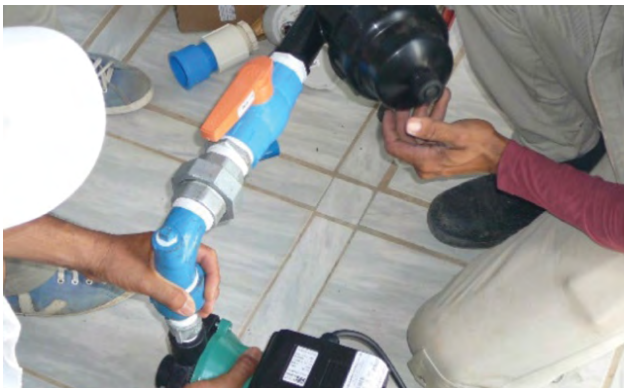
29 – Continuação das peças do recalque: Filtro de disco de 1.1/2”.
