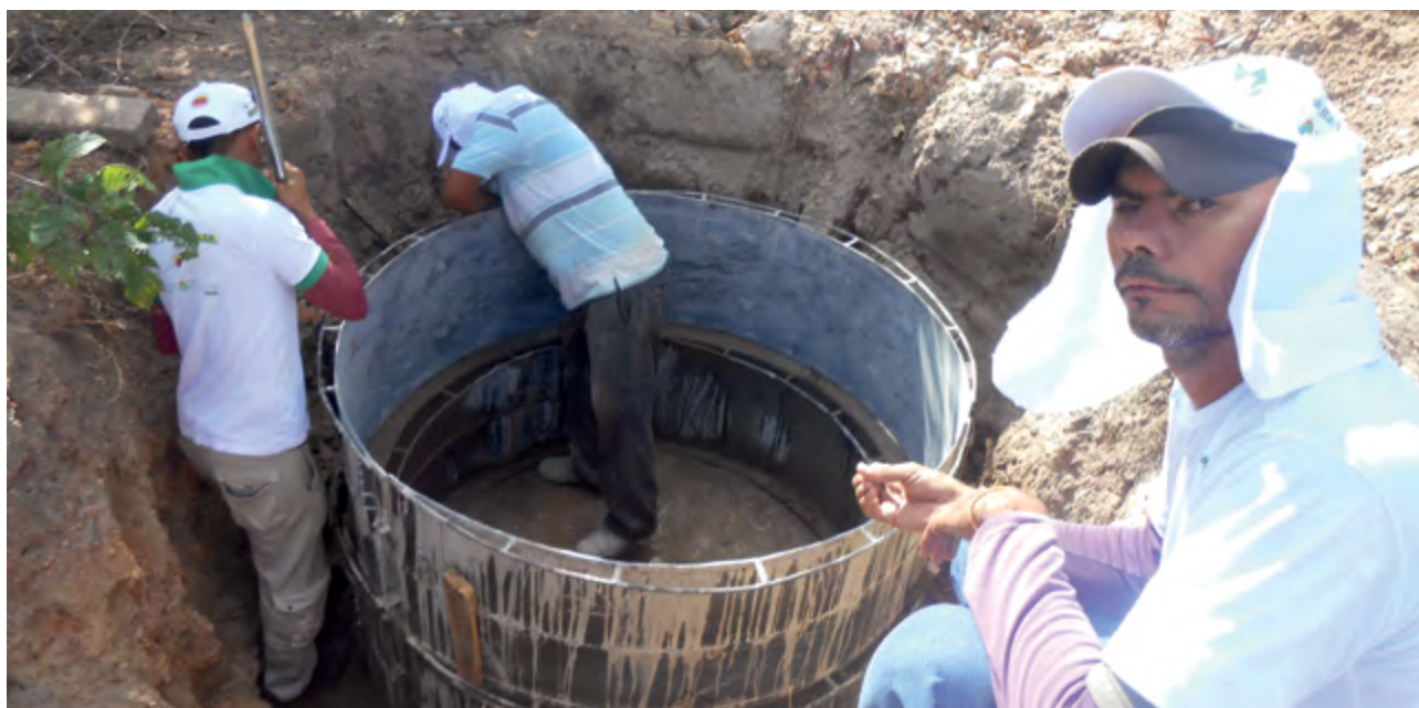
5 – Preencher a segunda forma com a argamassa e deixar repousando por 24 horas.
