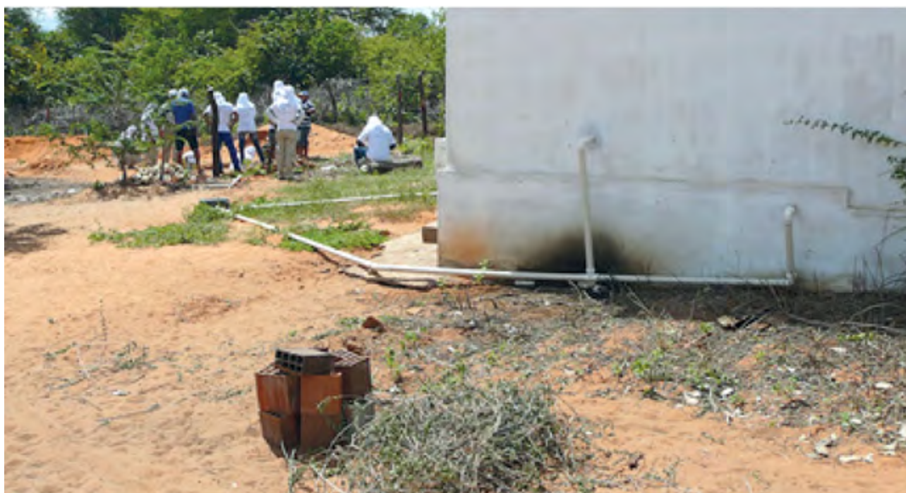
5 – Sistema de convergência pronto para a entrada na caixa de gordura.
