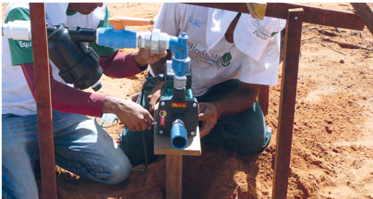
4 – Colocar um barrote de aproximadamente 70 cm (30 cm abaixo do solo) e uma tábua de 20 cm x 30 cm, para servir de base para a eletrobomba. Para fixar a eletrobomba na base são necessários 2 parafusos de \frac{1}{4} ".
