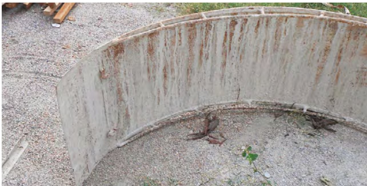
Figura 24. Peça curva interna da forma (1,82 m). Detalhes dos 27 cm a mais no final da peça (1,82 – 1,55).
