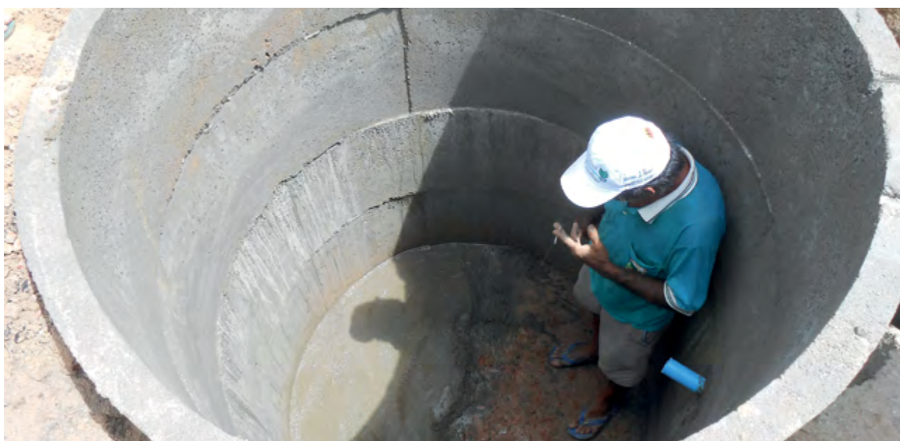
10 – O piso do tanque deve ser feito quando os anéis já estiverem completamente secos.
