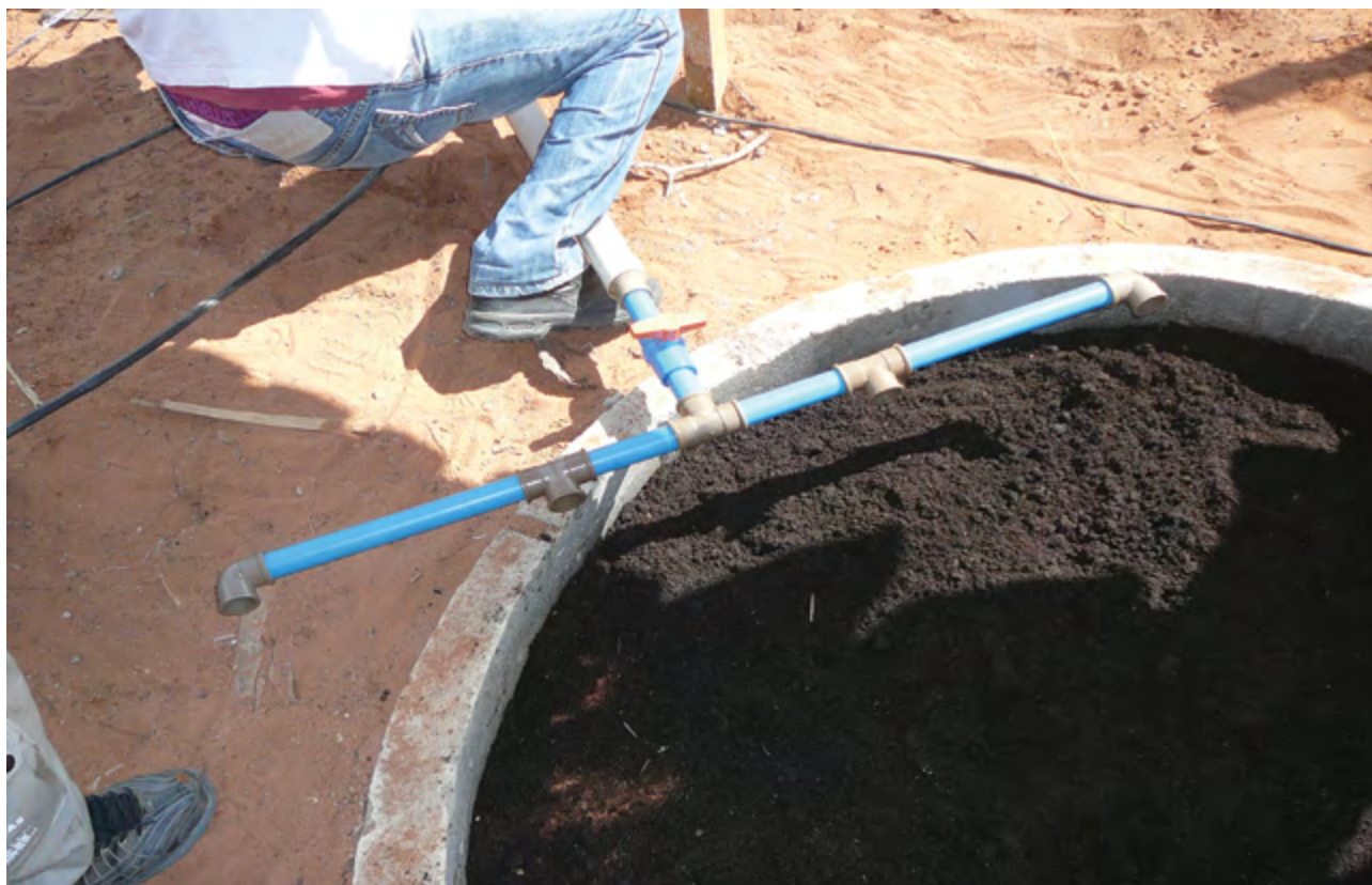
13 – Montagem do “chuveiro” que servirá para distribuir a água cinza no filtro biológico.
