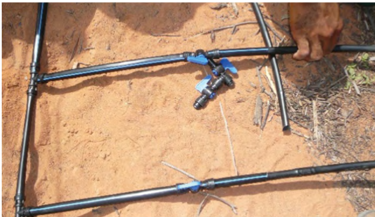
58 – Registro de polietileno de 16 mm para controlar a oferta de água para os canteiros de hortaliças.
