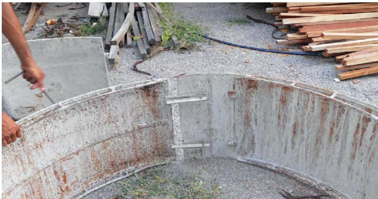
Figura 27. Peça curva interna 1,82 m sendo encaixada com peça de 1,55 m (que tem dois ferros que passam 25 cm).
