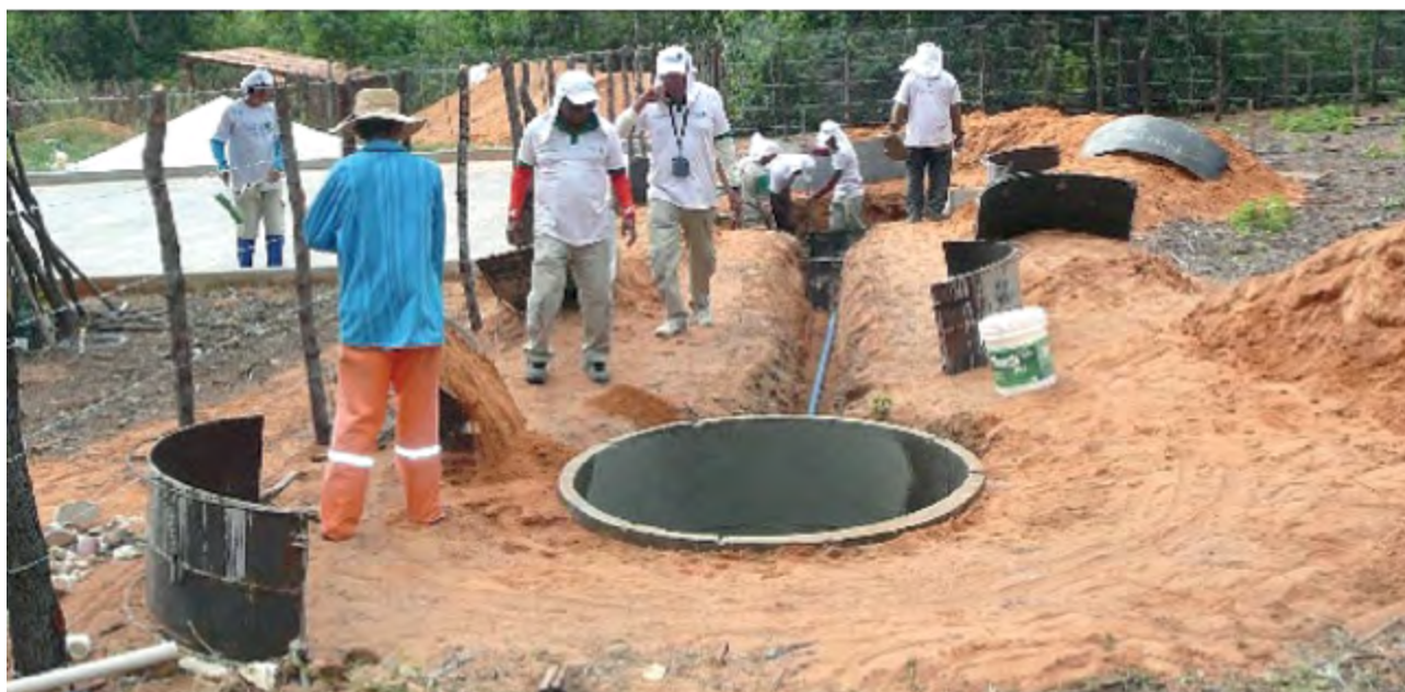
21 – Aterrando o tubo de PVC DN 50 que levará a água do filtro biológico para o tanque de reúso.
