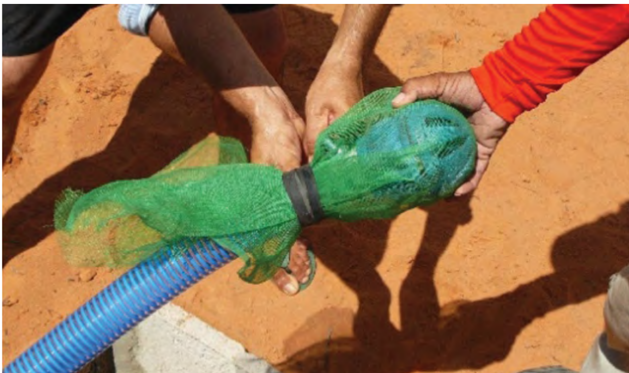
41 – Colocando a tela de proteção na válvula de pé para retenção de sedimentos.
