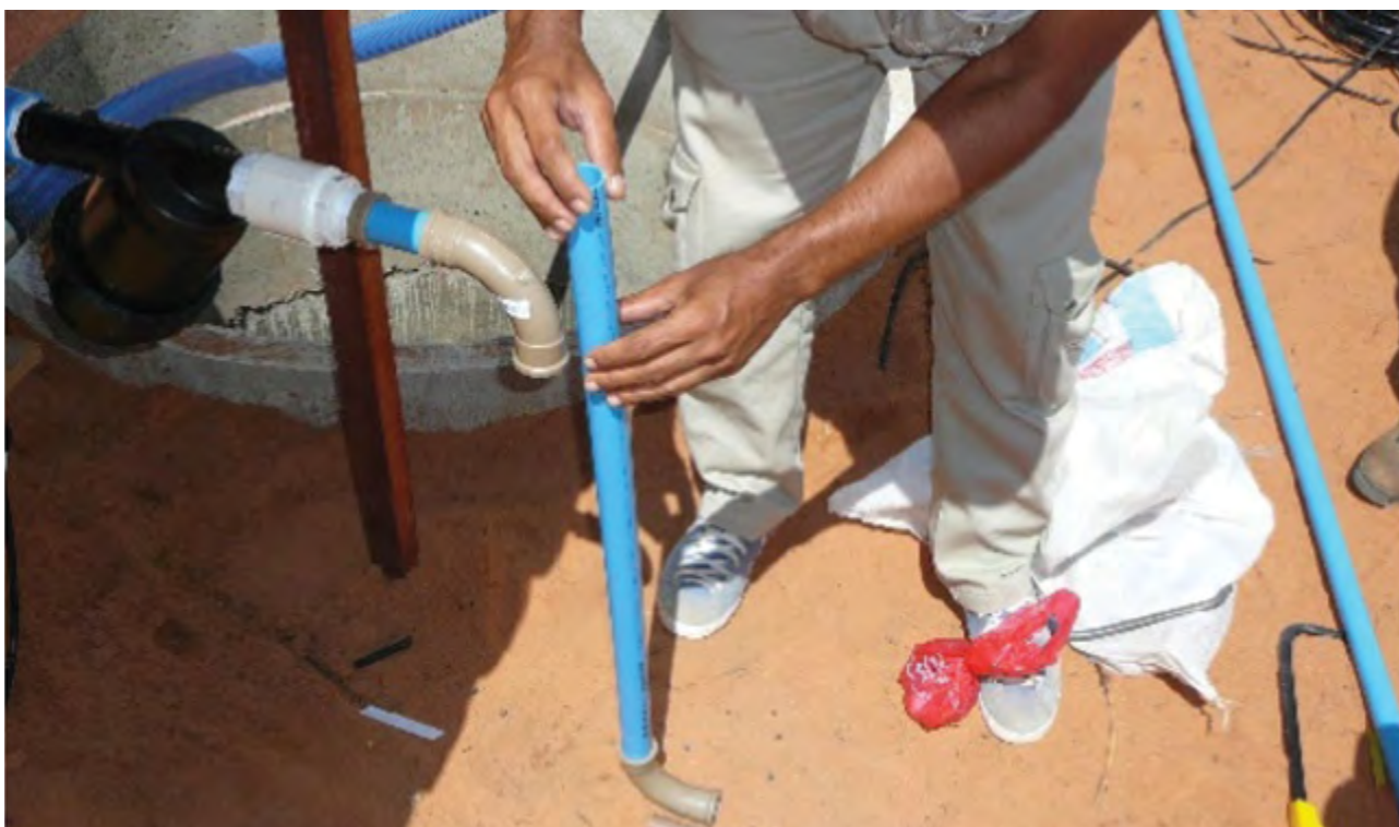
42 – Início da montagem do sistema de irrigação, conectando uma curva de PVC de 32 mm.
