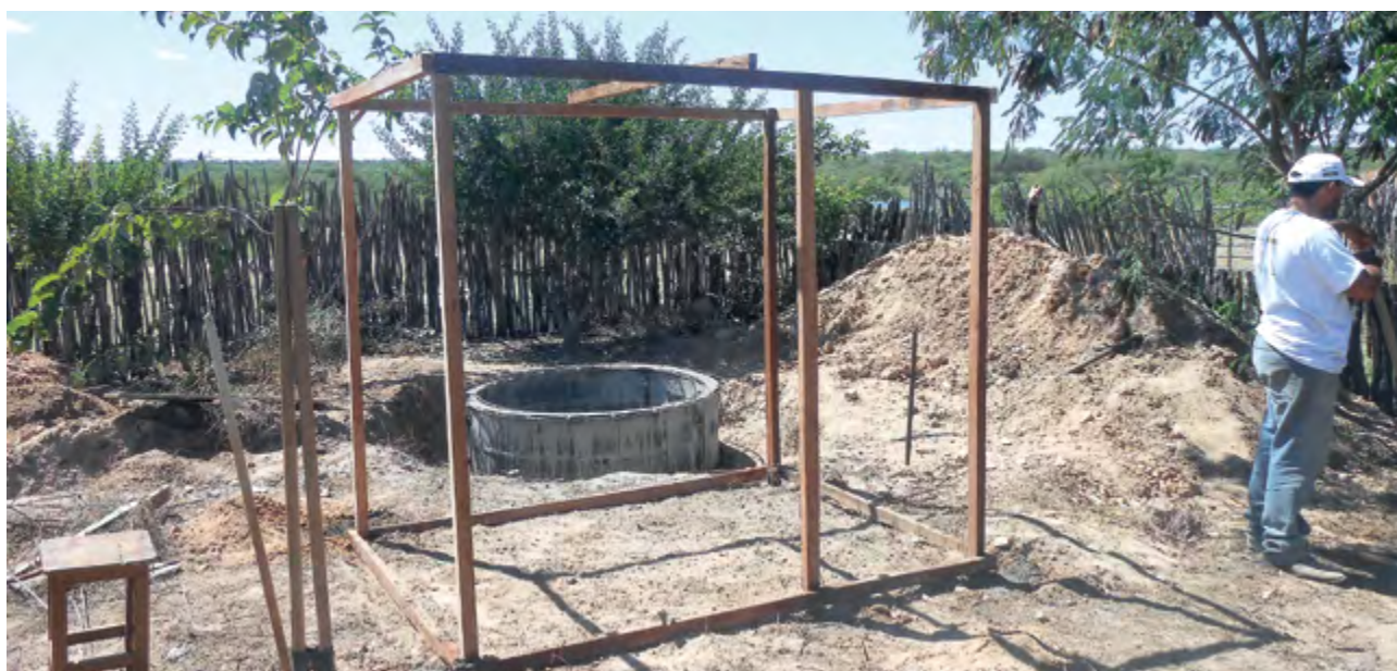
5 – Estrutura do minitelado finalizada.
