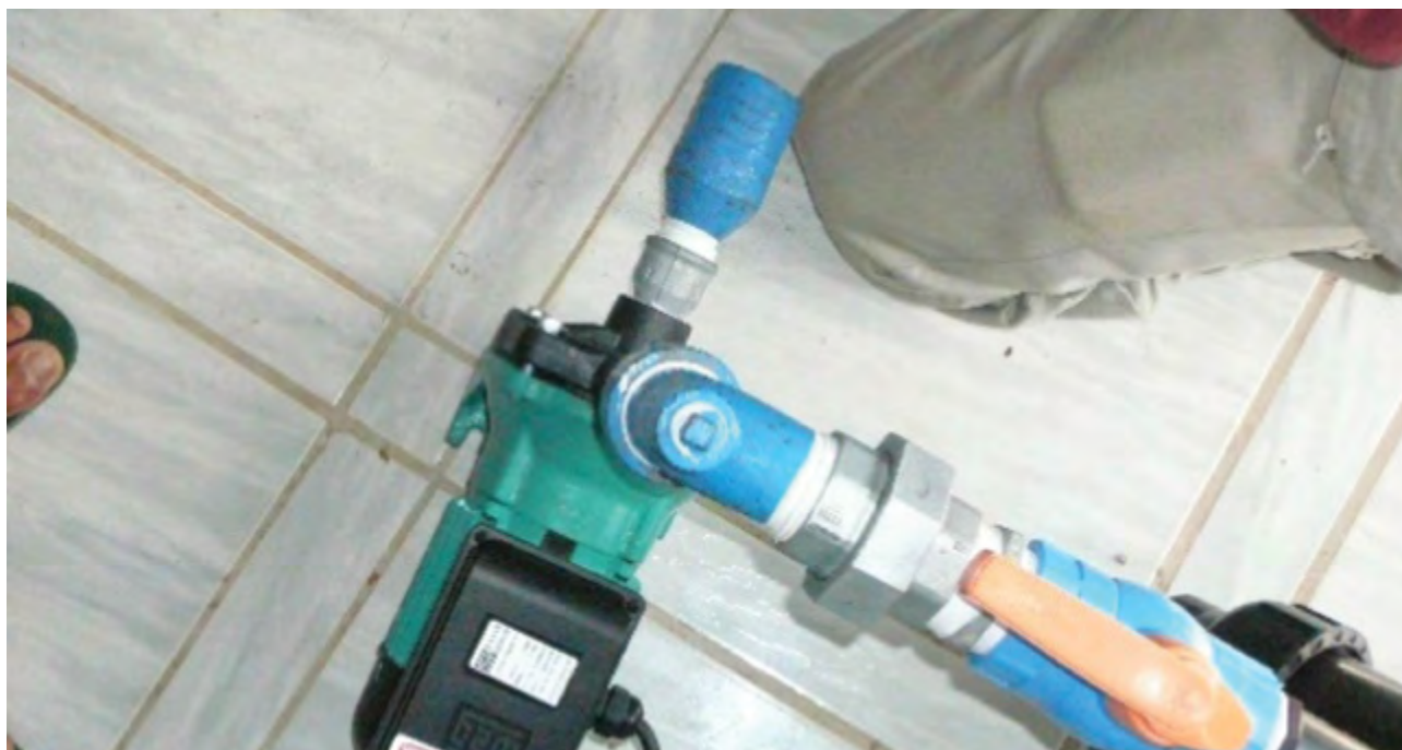
31 – Peças da sucção: Luva galvanizada de redução macho (3/4") x fêmea (1"), adaptador para mangote de 1" x 50 mm.
