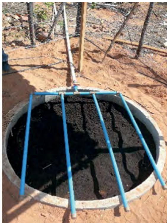
17 – “Chuveiro” pronto, no qual a água será distribuída uniformemente na superfície do filtro biológico. Nas extremidades de cada tubo de PVC, deve-se conectar cap de 32 mm.
