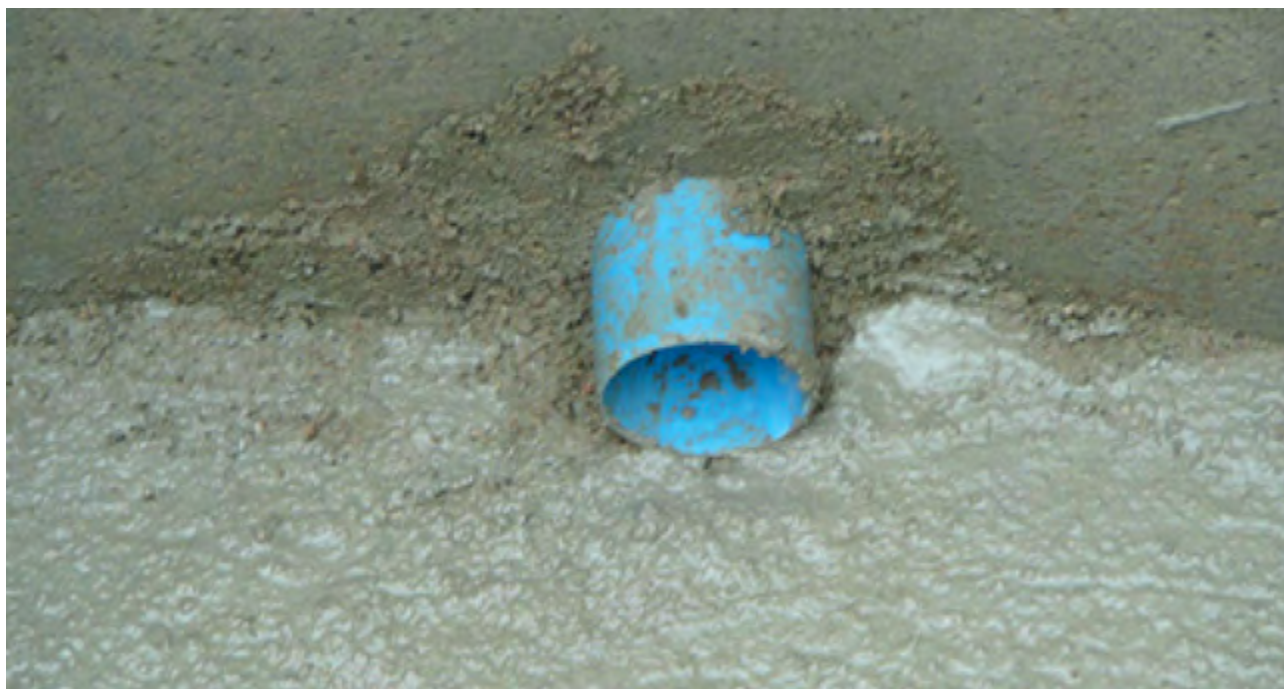
19 – Detalhe do tubo de PVC de DN 50 que levará a água tratada ao tanque de reúso.
