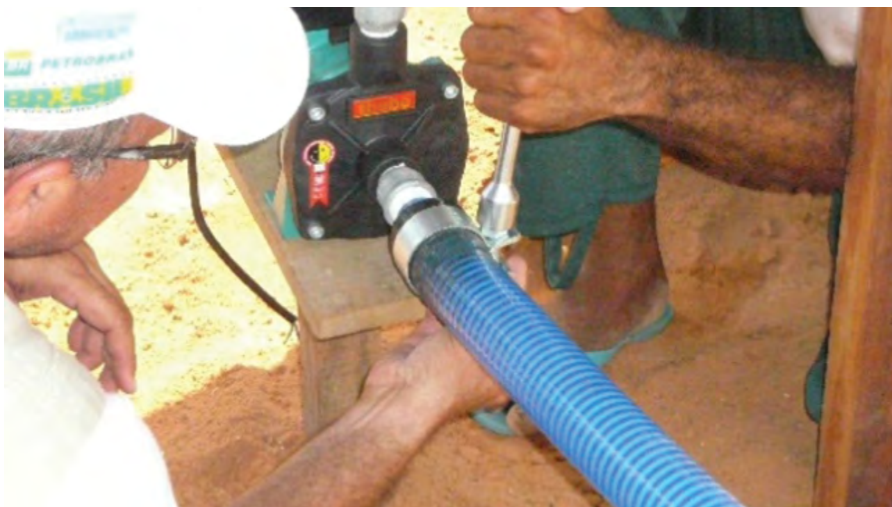
40 – Colocando a abraçadeira para mangote de 50 mm.
