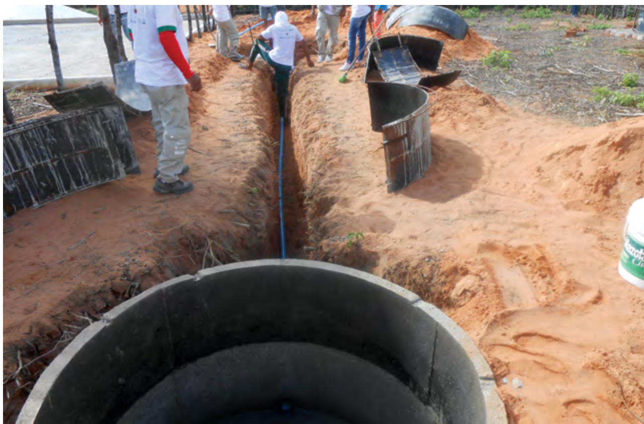
20 – Colocando tubo de PVC DN 50 que levará a água tratada para ser armazenada no tanque de reúso.
