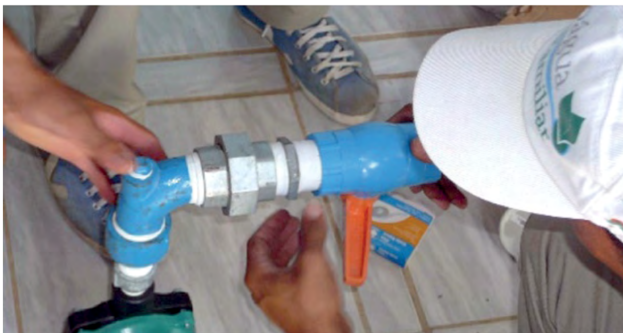
28 – Peças do recalque: Luva galvanizada de redução macho (3/4") x fêmea (1"), Luva galvanizada de redução macho (1") x Fêmea (1.1/2"), Curva galvanizada macho 1.1/2" (90°) com bujão, União galvanizada 1.1/2", Niple duplo galvanizado 1.1/2", Registro de esfera 1.1/2".
