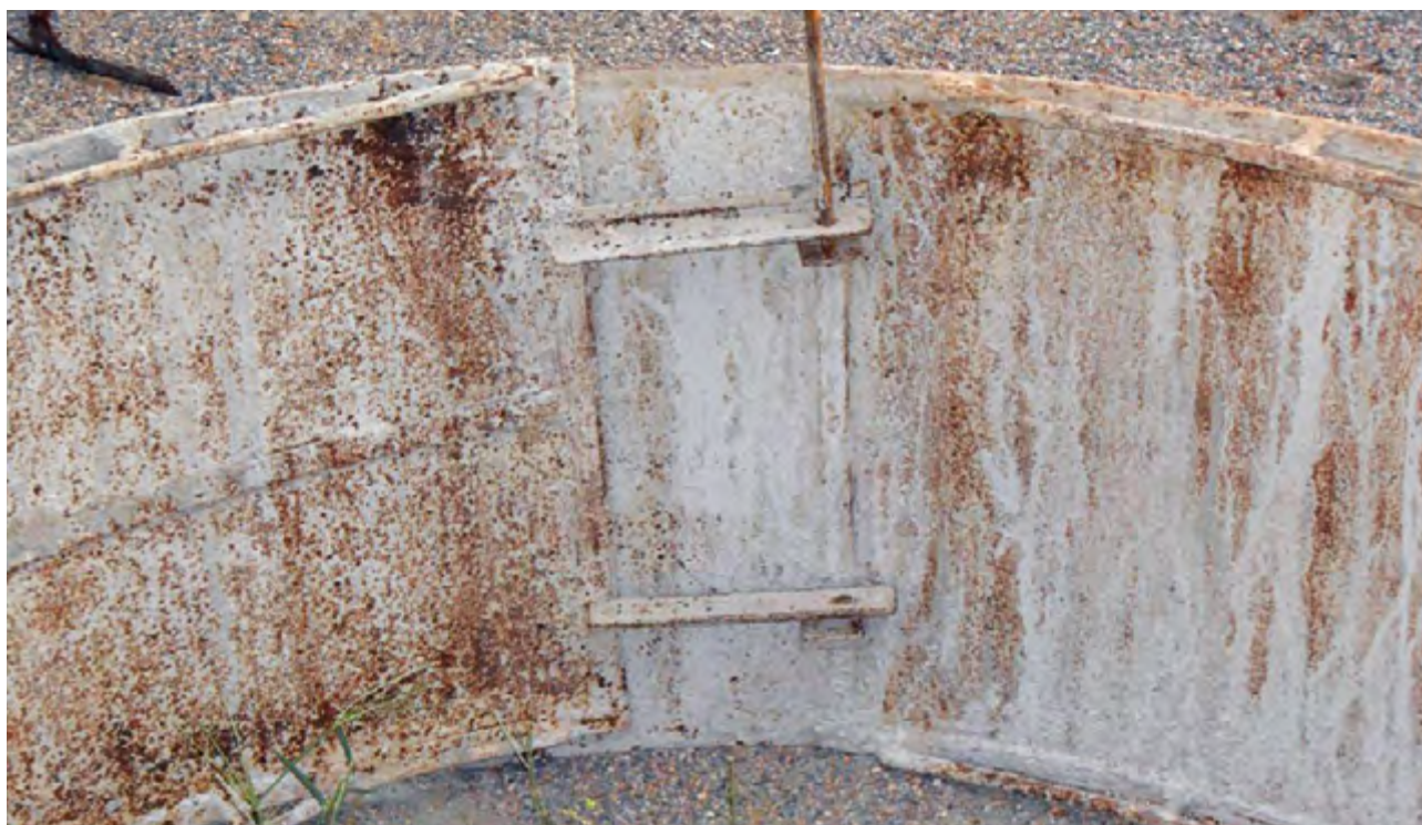
Figura 28. Detalhe da colocação do “pino de amarração”, unindo a peça curva interna de 1,82 m à peça de 1,55 m (que tem dois ferros que passam 25 cm).
