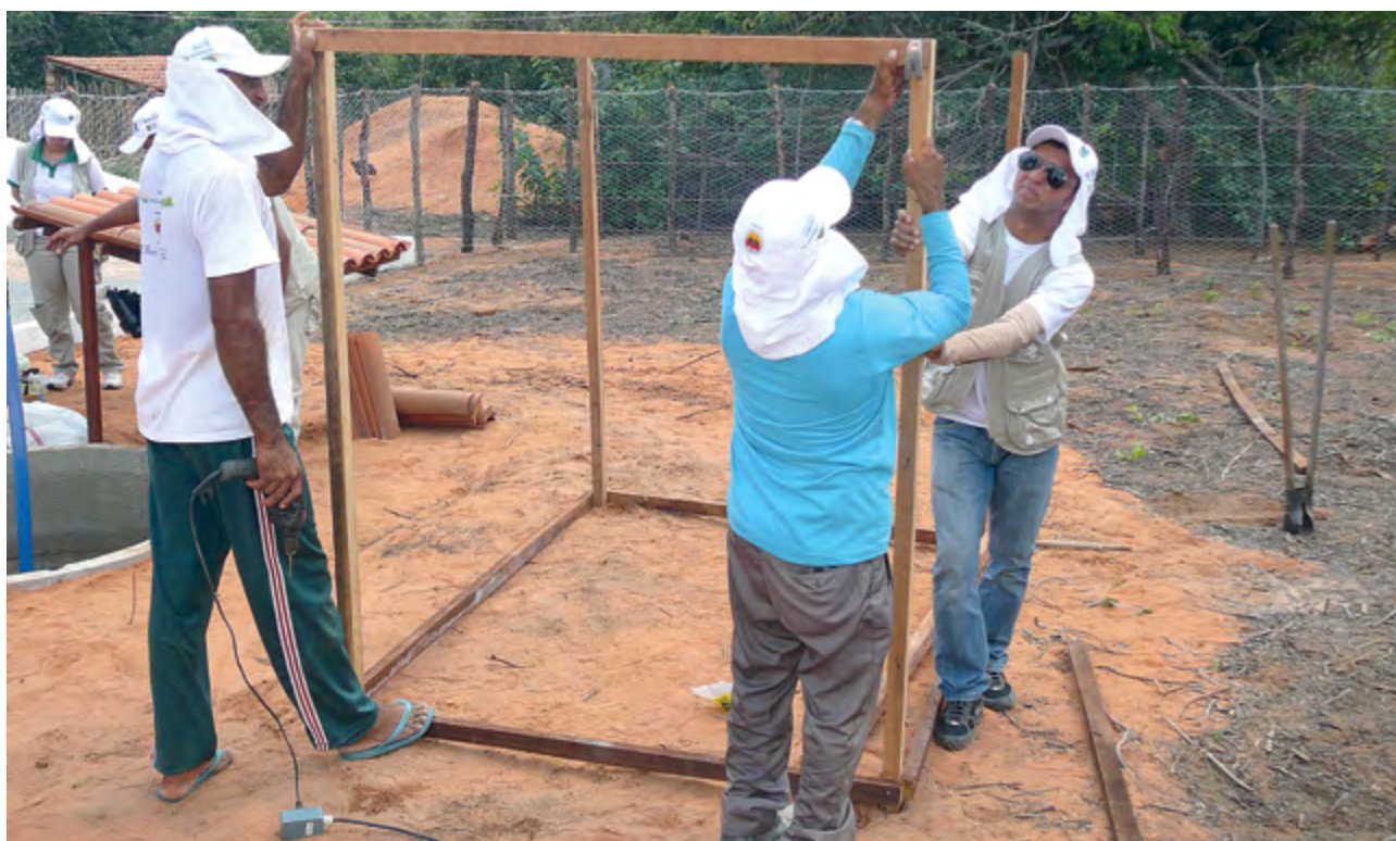
4 – Colocar 5 caibros para fazer a armação superior da cobertura e prendê-los com pregos.
