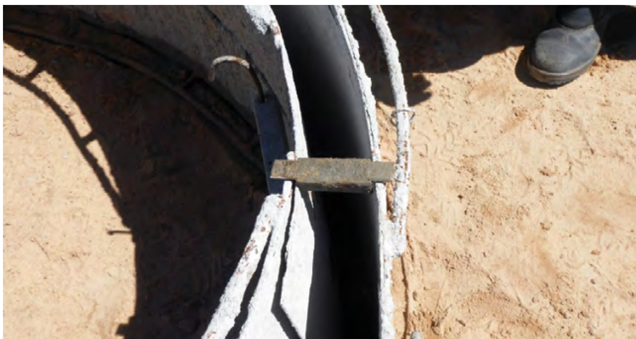
Figura 34. Vista detalhada da forma com partes interna e externa encaixadas.
