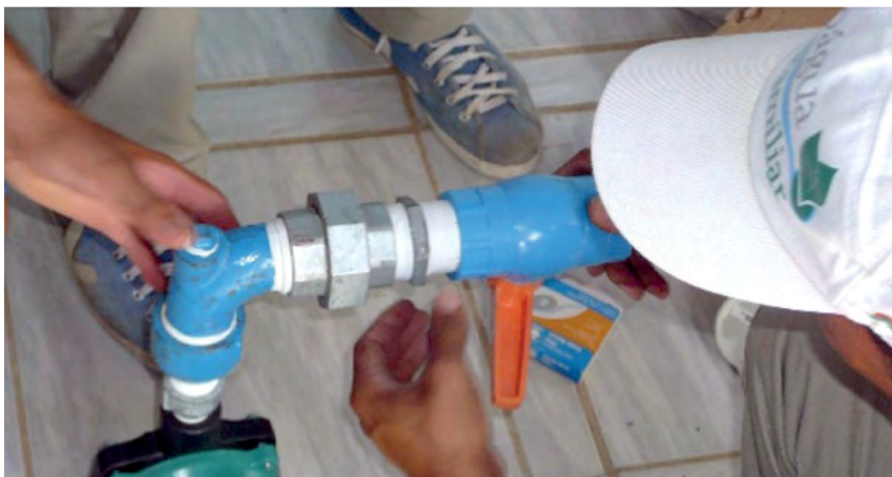
26 – Montagem do sistema de recalque.
