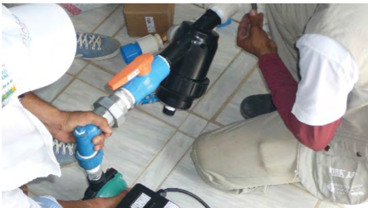
30 – Luva rosca plástica 1.1/2”, bucha de redução plástica de 1.1/2” x 1”, adaptador de 1” x 32 mm.
