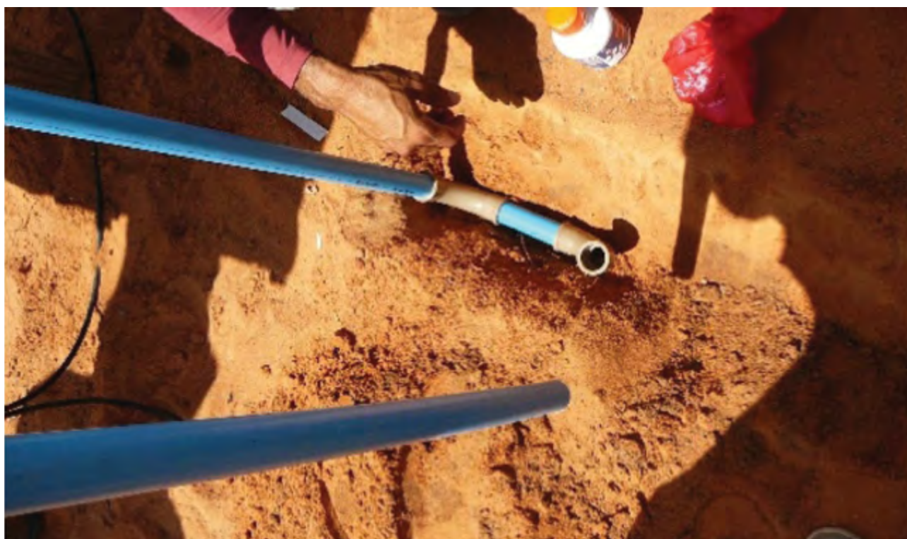
44 – Montagem do cavalete hidráulico: conectar uma curva de 90° de 32 mm, seguida de um tubo de PVC de DN 32 com aproximadamente 10 cm de comprimento e mais uma curva de PVC de 90° de 32 mm.
