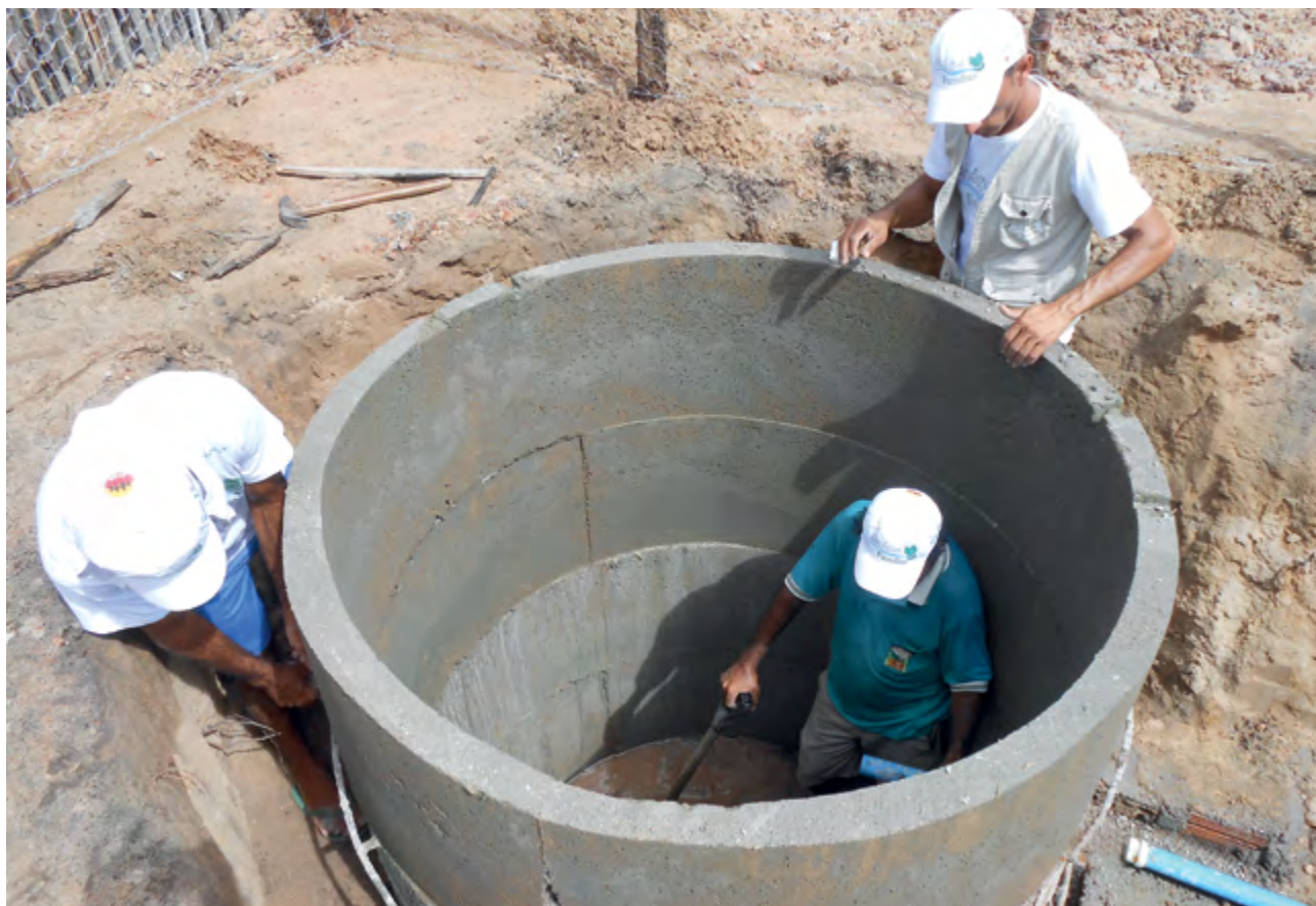
9 – Não se deve retirar as formas antes de completar as 24 horas, pois há risco da argamassa quebrar.
