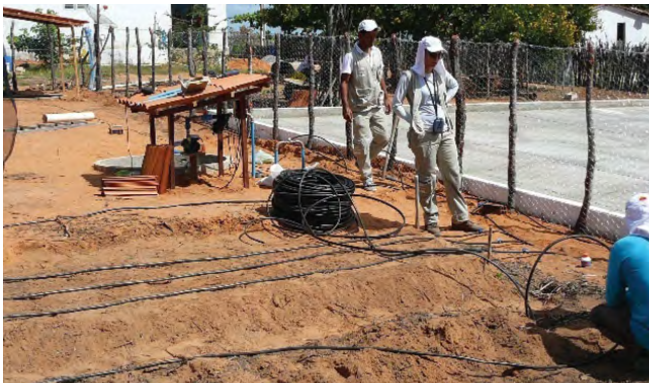
60 – Distribuição das linhas laterais de polietileno DN 16 com gotejadores para canteiros de hortaliças e mudas de fruteiras.
