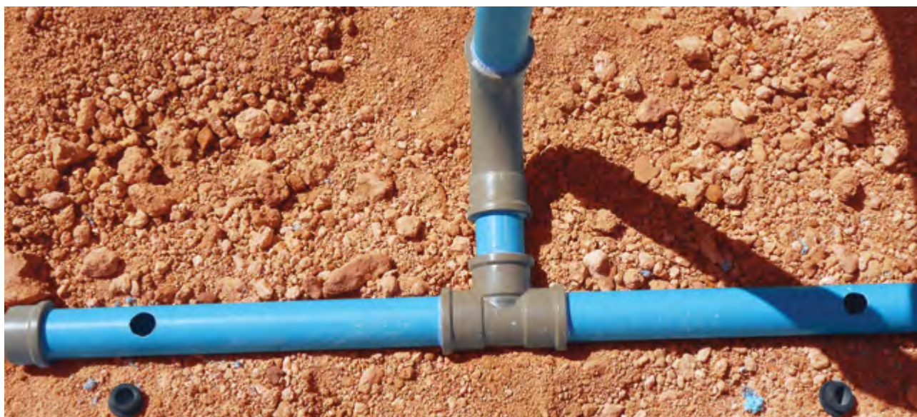
49 – Aberturas nos canos de 32 mm para a conexão das chulas de 16 mm e dos conectores de início de linhas de derivação de DN 16.
