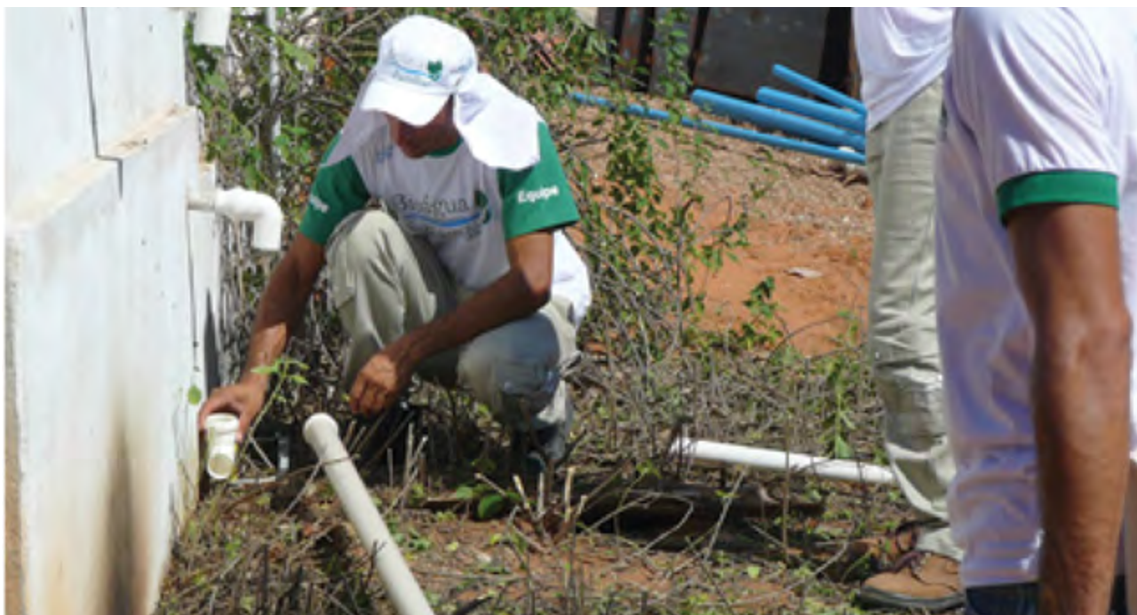
3 – Conectando a tubulação para a convergência da água cinza na caixa de gordura (água utilizada nas pias da cozinha).
