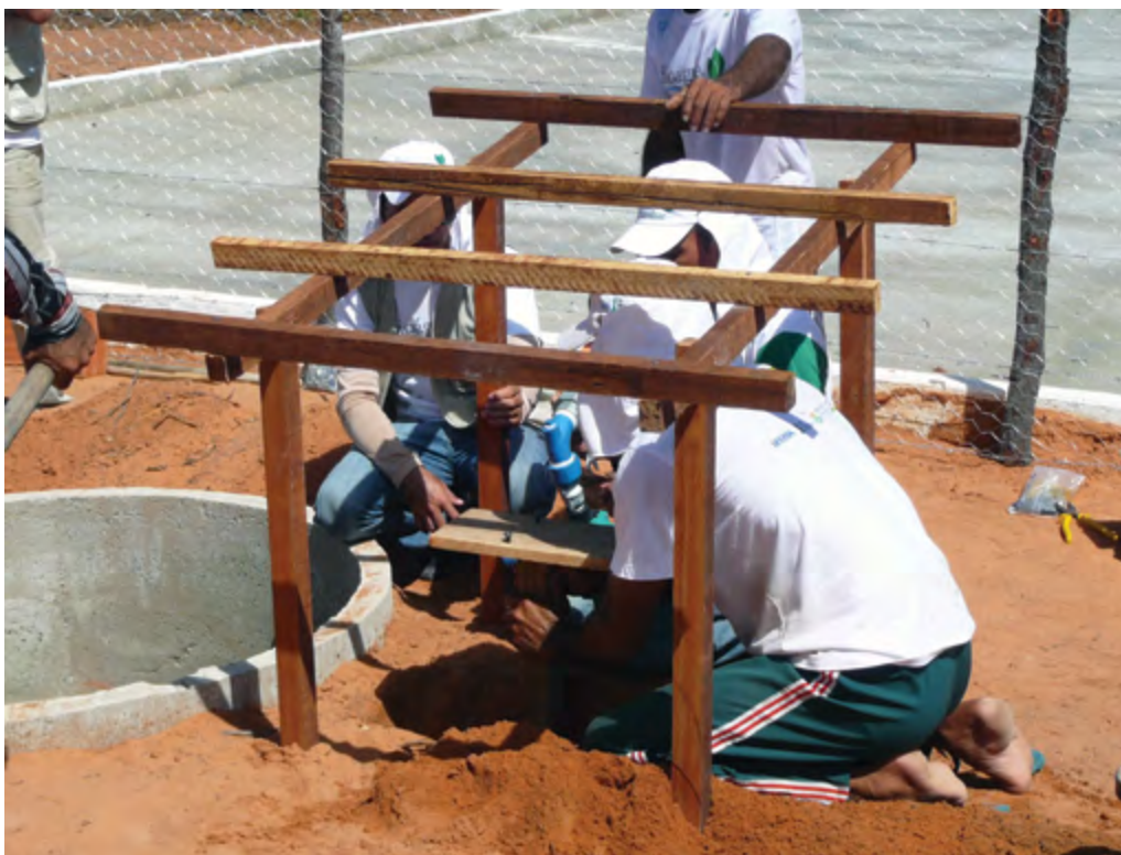
3 – Colocar 4 caibros com distância de 40 cm entre eles no sentido contrário as águas.
