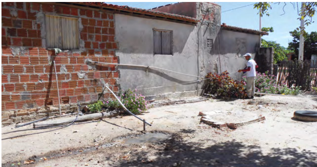
1 – Observar quais são e onde se localizam as saídas de água cinza da residência.
