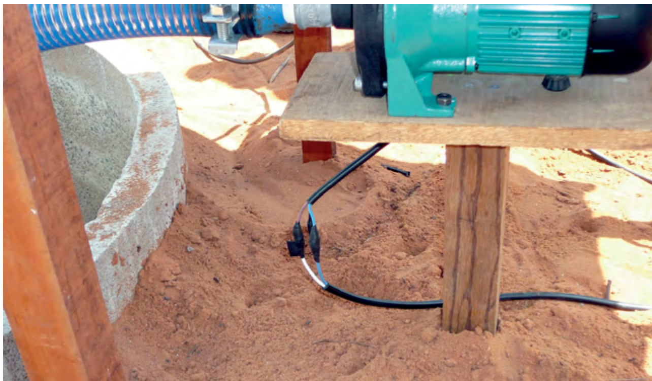
14 – O fio de aterramento da eletrobomba também deve ser isolado.
