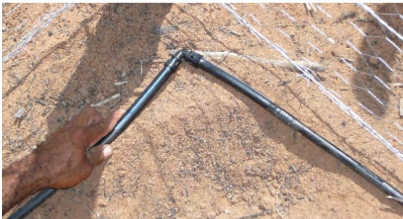
57 – Joelho de polietileno de 16 mm x 90° para conectar as extremidades da mangueira e contornar área do SBF.
