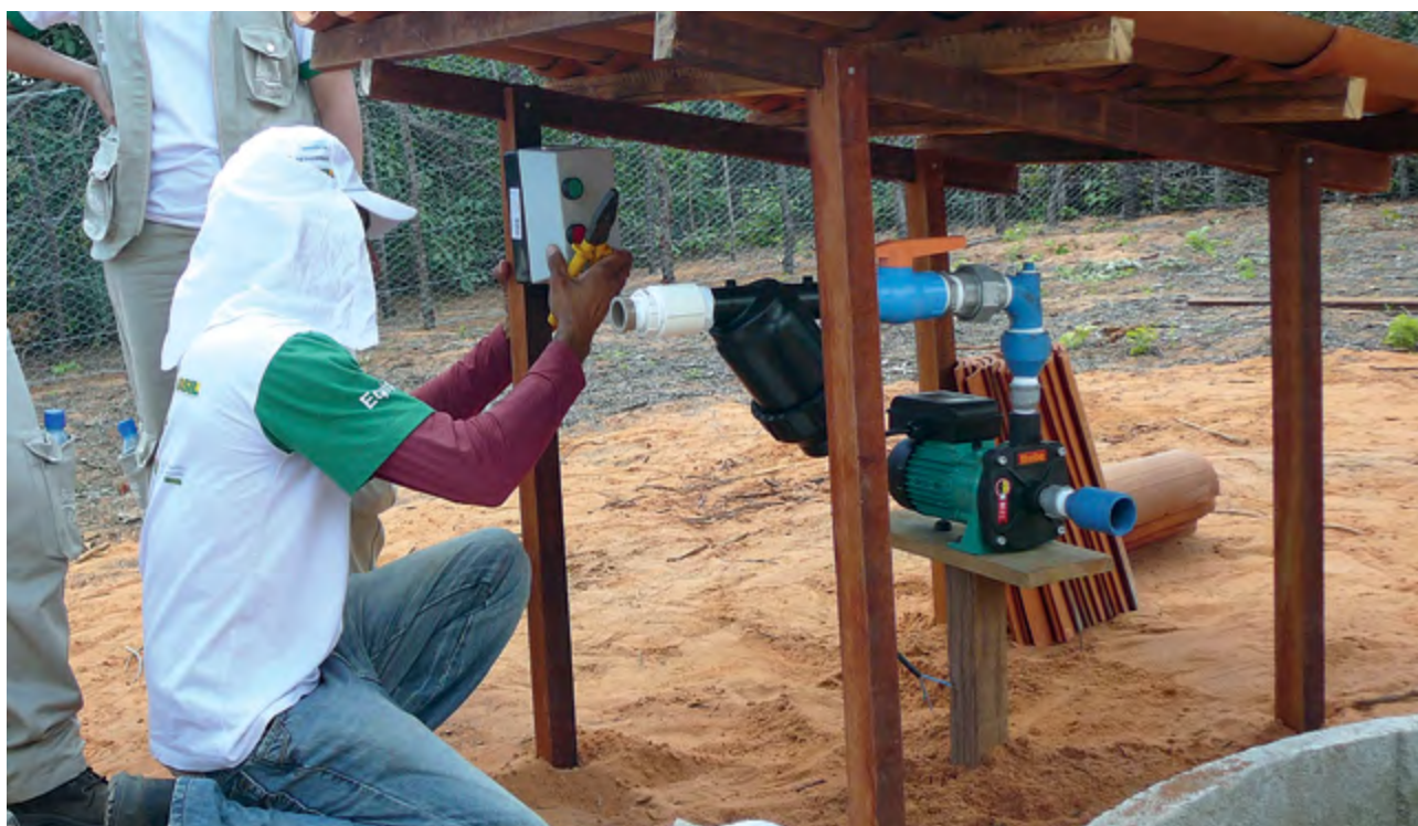
33 – Saída do recalque para o sistema de irrigação.
