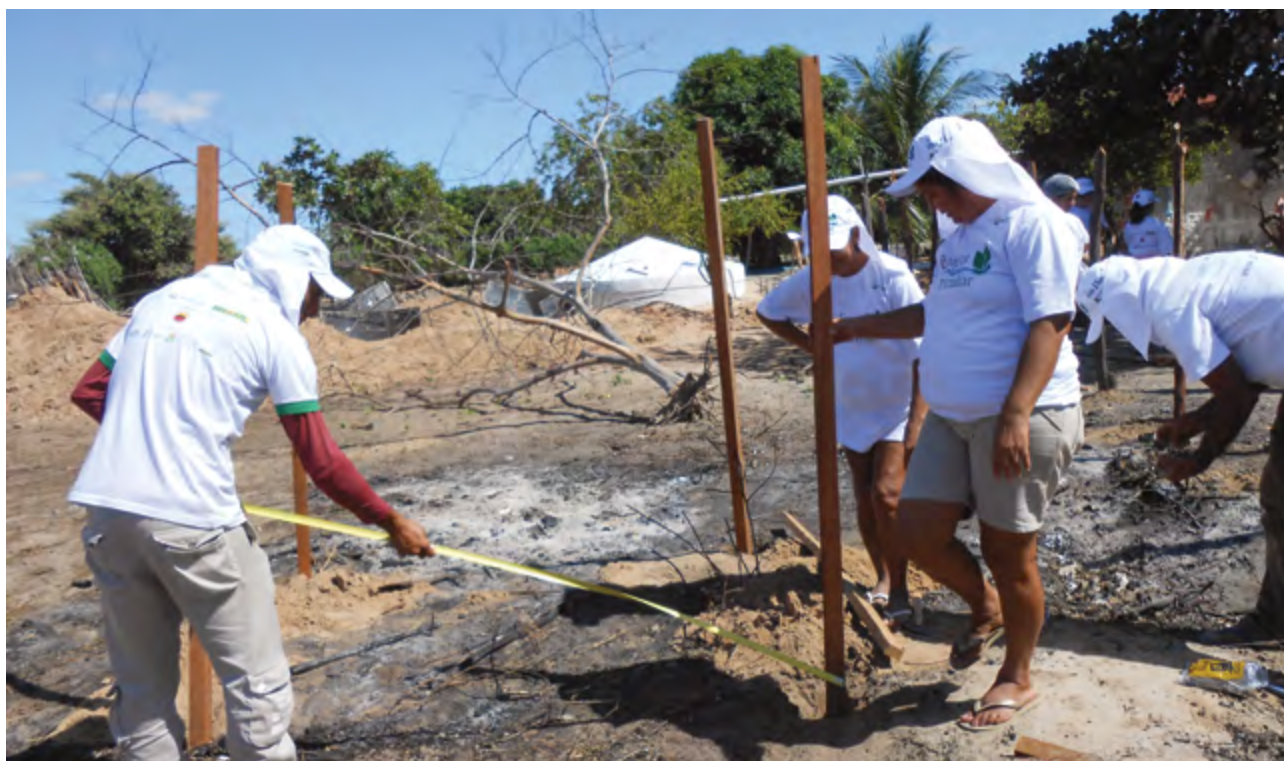
2 – Dois barrotes devem ser colocados a uma distância de 2 m formando a base maior, e os outros 2 a 1,5 m formando a base menor.
