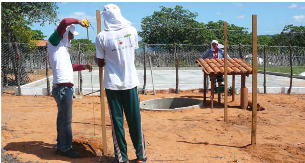
1 – Colocar 4 barrotes de 2,50 m de altura enterrados 70 cm, ficando 1,80 m acima do terreno.
