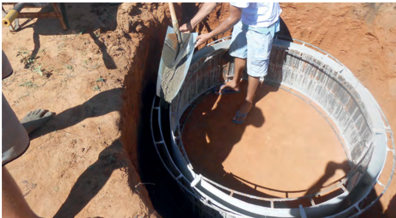
4 – Preencher a primeira forma na parte interior do buraco e deixar secando por 24 horas.
