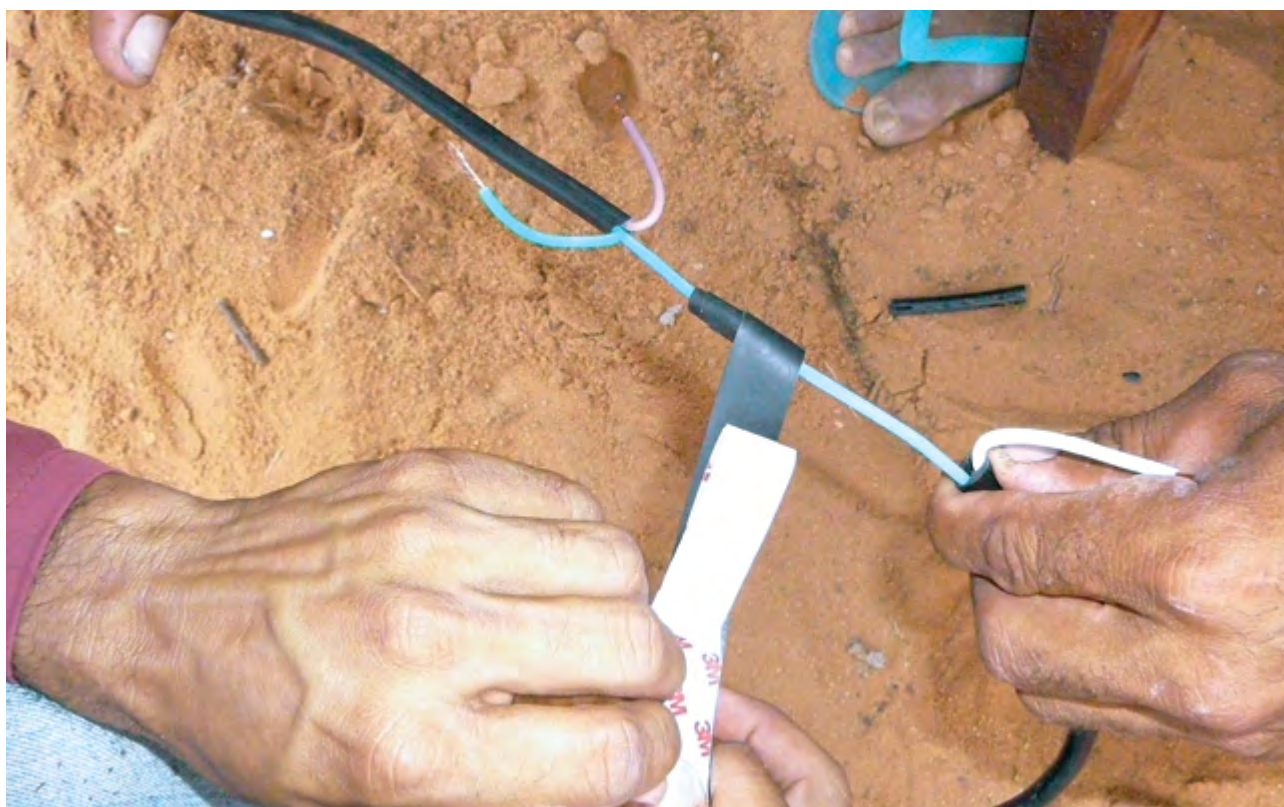
12 – Fazer o isolamento dos fios com fita de alta fusão.
