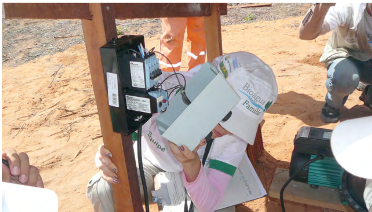
8 – Procedimentos para ligar a fiação na chave magnética: perfurar um buraco na parte inferior para a entrada dos fios de energia (o primeiro fio vem da residência e o segundo sai da chave para a eletrobomba).
