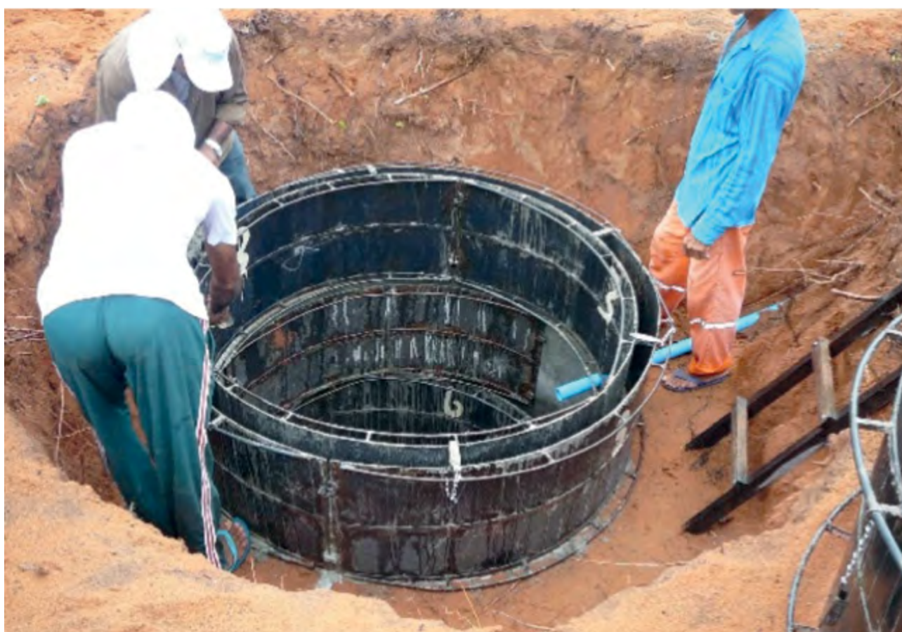
22 – Entrada do tubo de PVC DN 50 no tanque de reúso 1 m acima do piso.
