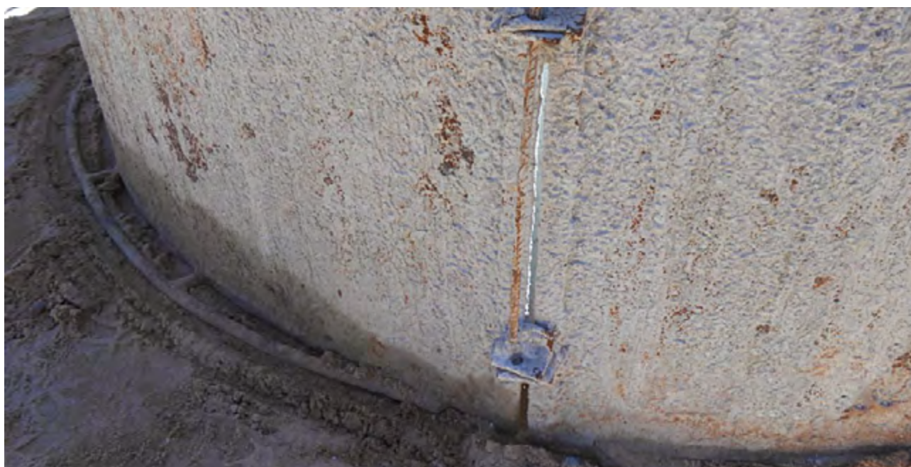
Figura 31. Detalhe da colocação do “pino de amarração” entre duas peças externas.
