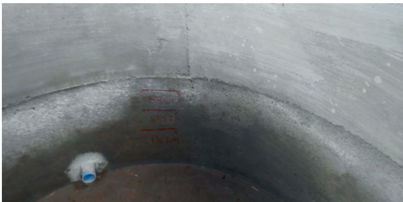
10 – Fazer marcações na parte interior dos anéis para demarcar as espessuras de cada camada filtrante.
