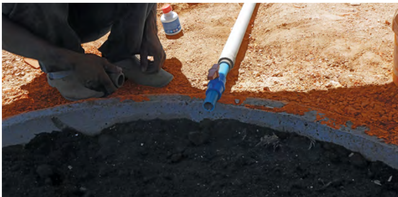
12 – Deve-se usar um registro de passagem soldável de DN 32 de modo a permitir o controle da entrada de água cinza no filtro biológico. Atentar para a necessidade de colocar um pedaço de tubo de PVC de DN 32, tanto na conexão da redução de 32 mm quanto para a junção ao Tê de 32 mm do “chuveiro”.
