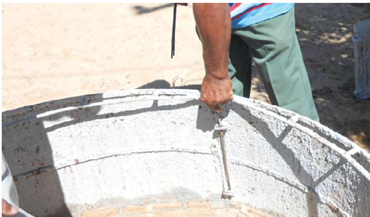
Figura 26. Encaixe de duas peças curvas internas de 1,55 m através de um “pino de amarração”.
